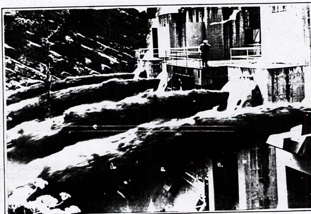
Photo 55- C'est en pratiquant ce type de soutirage qu'on arrive à protéger la durée de vie de nos barrages
