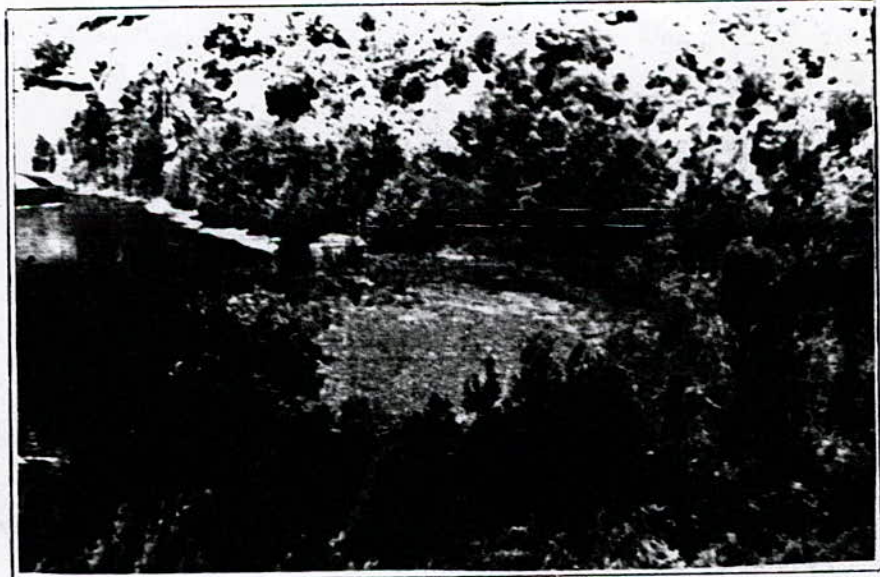
Photo 51- Aval du barrage d'IGHIL EMDA. Après quelques années, la vase évacuée par le soutirage est colonisée par une abondante végétation
