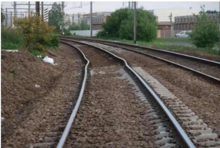
Figure 1.20. Exemple de flambement d'une voie ferrée
