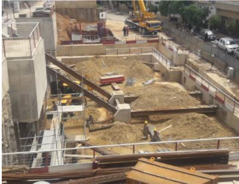
Figure 4. 10 Butonnage incliné
