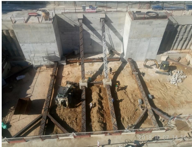
Figure 4. 12 Installation du 1er niveau du butonnage
