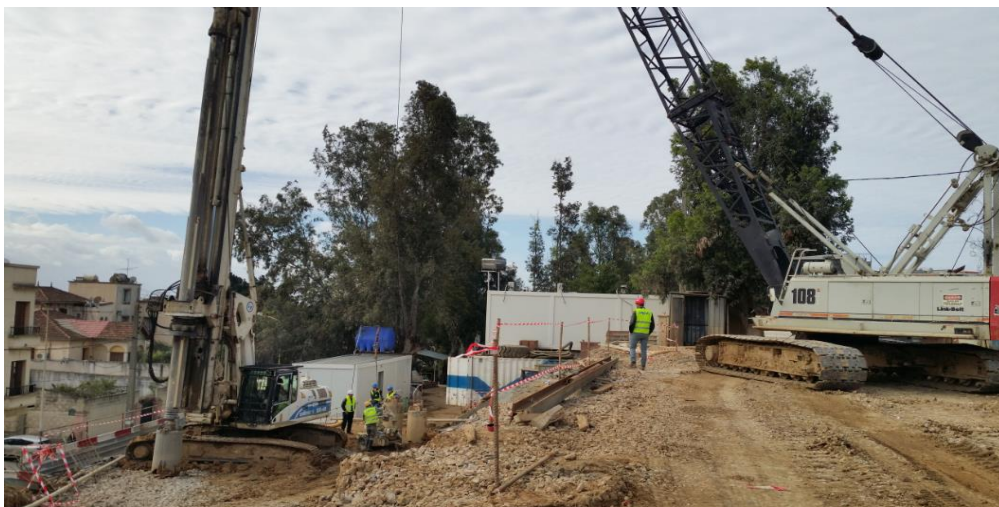
Figure 4. 3 Photo prise lors de l'exécution du pieux[2]
