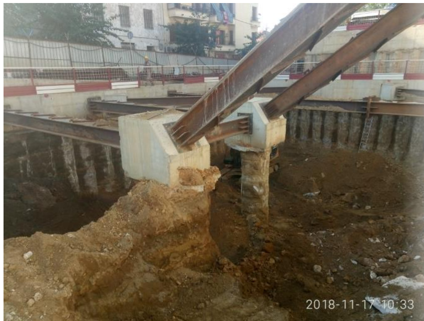
Figure 4. 13 Excavation jusqu'au deuxième niveau de butonnage
