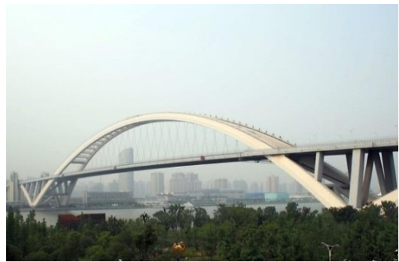
Figure I.3 : Pont en arc
