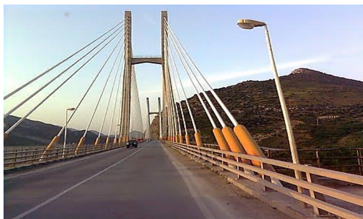
Figure II.10 : Vu des haubans.
