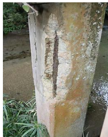
Figure I.10 : Eclat dans une pile carrée
