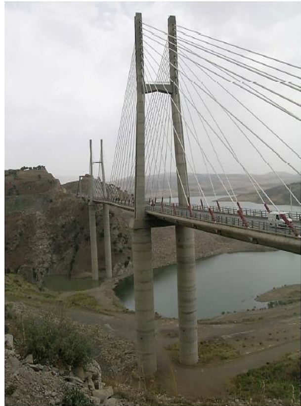
Figure II.8 : Vue du pylône droit
