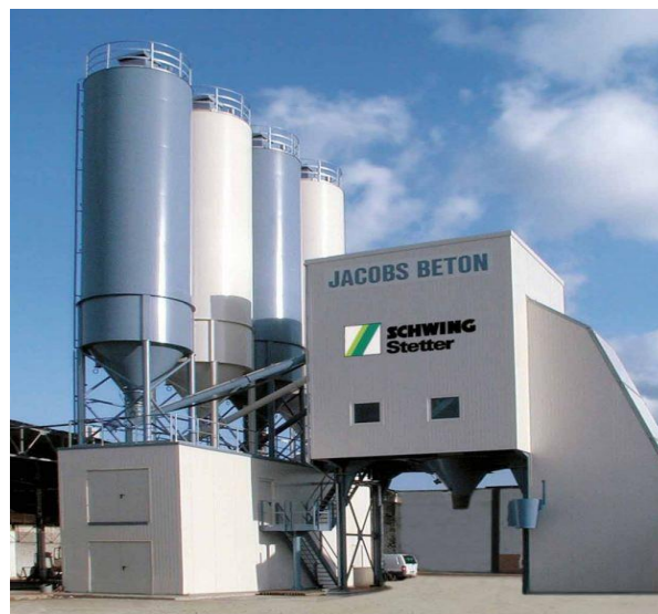
Figure IV.4 : Centrale à béton HN1.5 de 80m 3 /h
