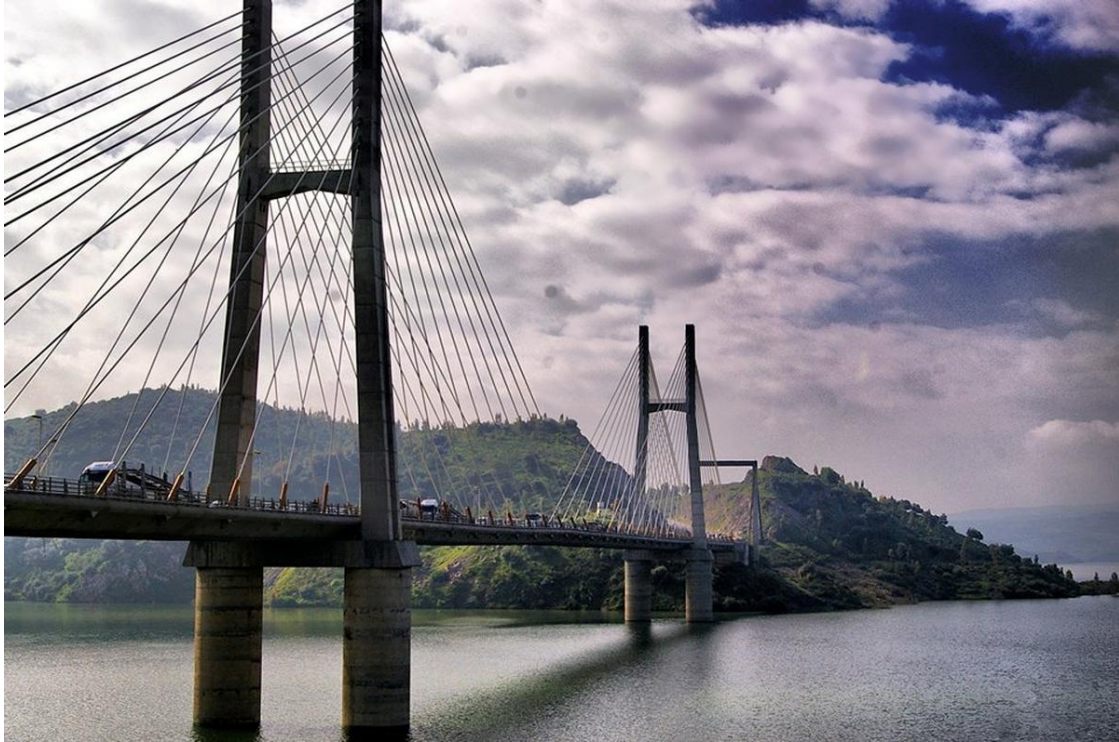
Figure 5 le pont de oued Dib à Mila [25]
