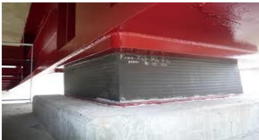
Figure 10-2: appareil d'appuis en élastomère fretté de type B
