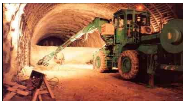
Figure I-7: Creusement en demi-section [6]
