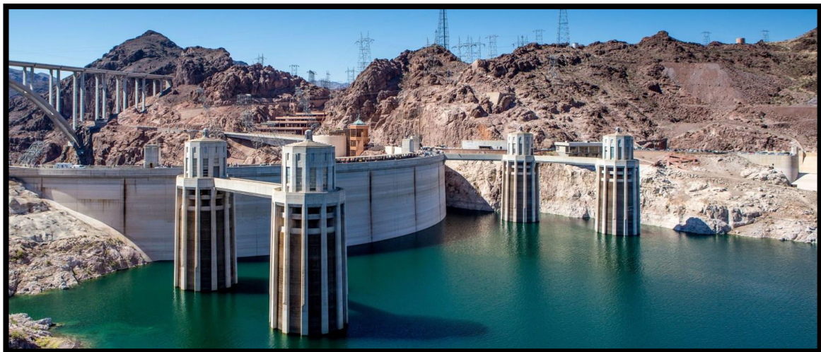
Figure I-2 Tours de prise du barrage de Hoover, Nevada
