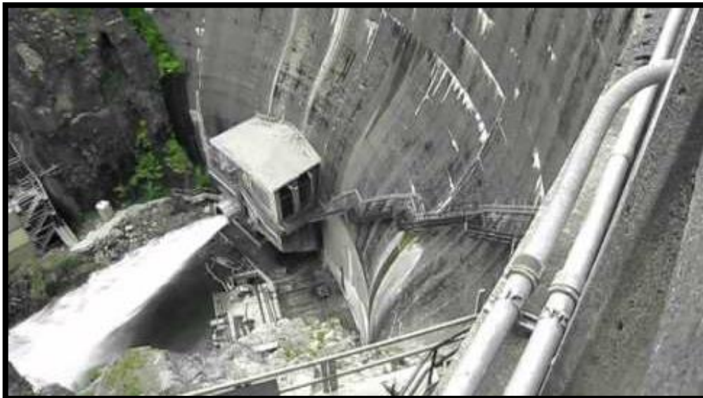
Figure I-3 Vidage de fond du barrage de Cushman, Washington
