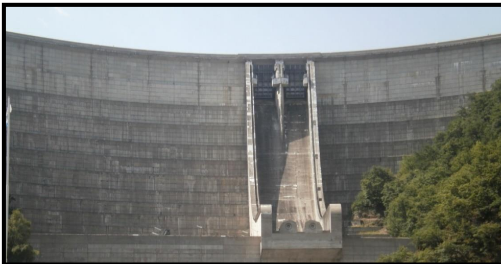
Figure I-1 Evacuateur de crue du barrage de Bort les orgues, France
