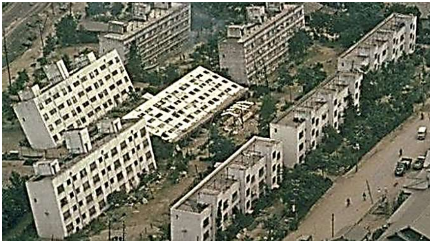
Figure 1.1-3: Inclinaison des bâtiments d'appartements de Kawagishi-cho à Niigata au Japon dues à la chute de la capacité portante du sol par liquéfaction (Peter M. Byrne et al, 2008).
