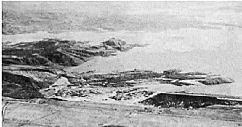
Figure 1.1-2: Vue aérienne de la rupture de barrage de Fort Peck (corps des Ingénieurs de l'armée des États-Unis, 1939, d'après Mike Jefferies et Ken Been, 2006)[1]
