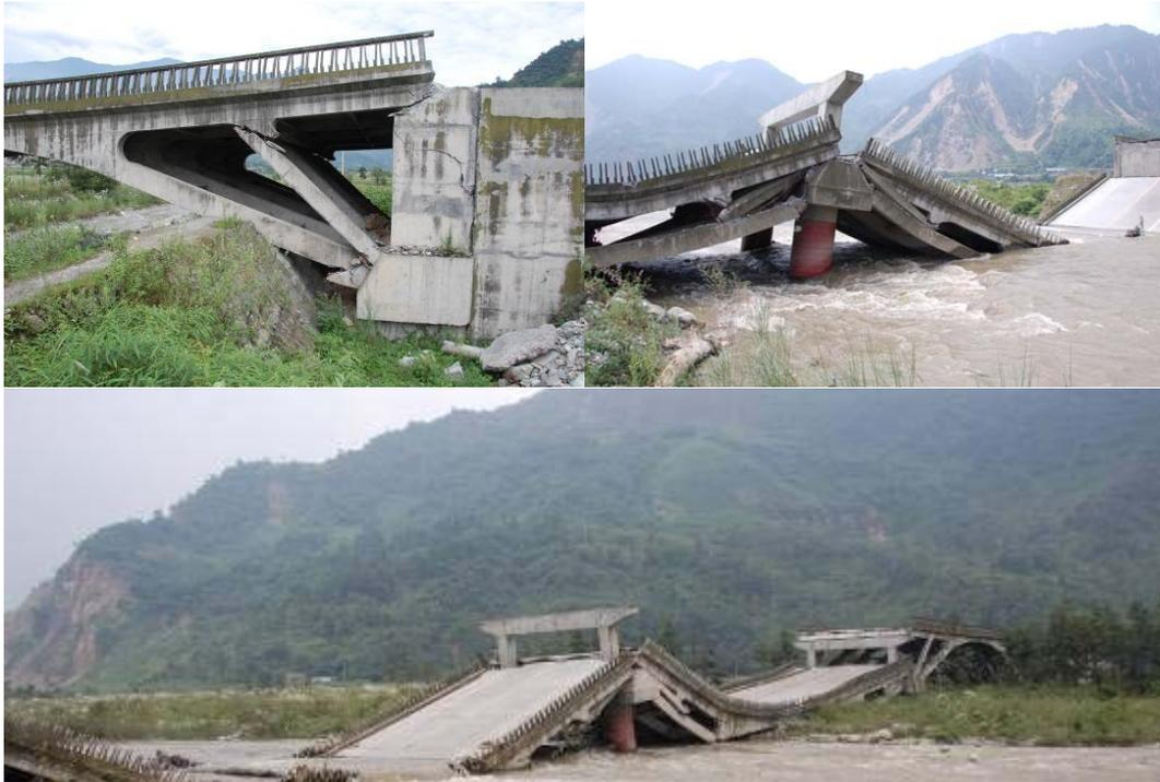
FIGURE 1.22 – Rupture du Pont de Xiaoyudong lors du séisme de Wenchuan
