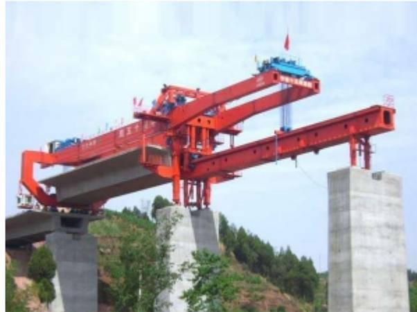
FIGURE 1.11 – Utilisation d’un lanceur de poutre pour la construction d’un pont
