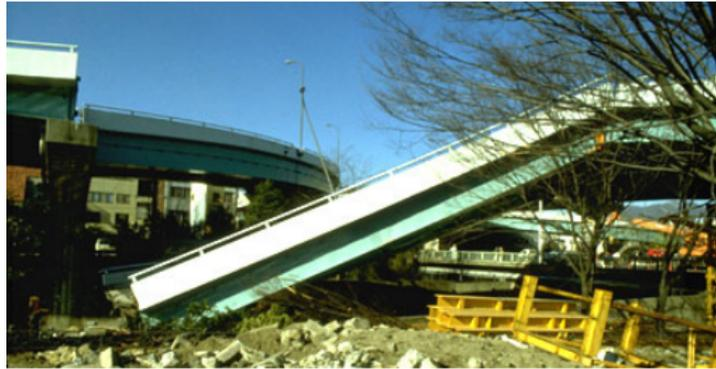
FIGURE 1.18 – Chute du tablier d'un pont lors du tremblement de terre de Kobe 1995
