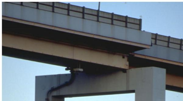
FIGURE 1.19 – Déplacement latéral du tablier et chute des appuis sur palée d'un pilier à Kobe en 1995
