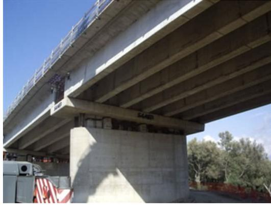
FIGURE 1.9 – Pont à poutres sous chaussée
