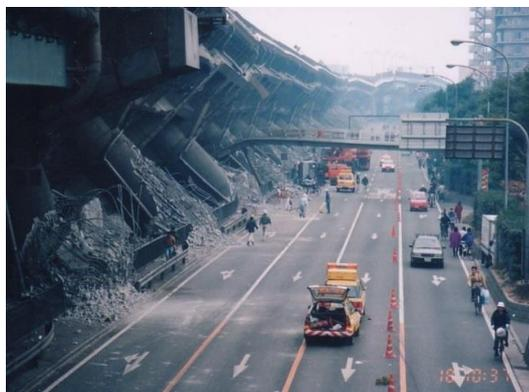
FIGURE 1.23 – Effondrement d'un viaduc lors du séisme de Kobe (1995) en raison de la liquéfaction du sol
