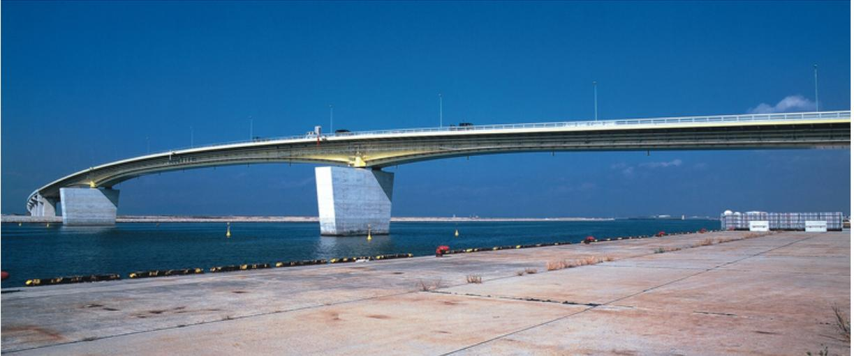
FIGURE 2.6 – Pont de Kishinoue au Japon équipé d'isolateurs sismiques.
