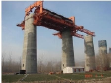
FIGURE 1.13 – Pont en construction sur cintres autoporteurs
