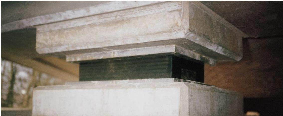
Figure XI.1 : Appareil d'appui en élastomère fretté.
