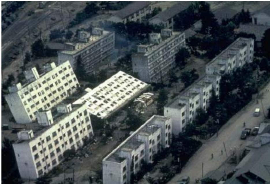
Figure 1 - 3 : Inclinasion des bâtiments d'appartements de Kawagishi-cho à Niigata au Japon dues à la chute de la capacité portante du sol par liquéfaction (d'après Peter M. Byrne et al, 2008).
