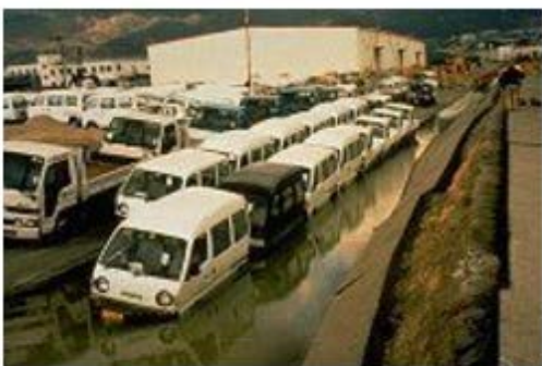
(c) Déplacement latéral : 1,2 - 2m de la surface pavée avec inondation locale.
