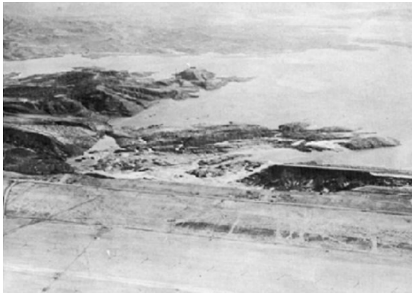
Figure 1 - 2 : Vue aérienne de la rupture de barrage de Fort Peck (corps de l'armée des États-Unis d'Ingénieurs, 1939, d'après Mike Jefferies et Ken Been, 2006)
