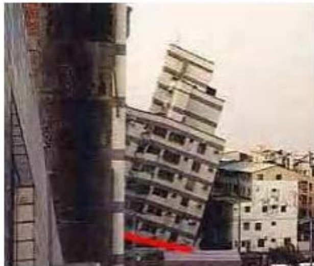
Figure 1 - 15 : Bâtiments renversés à TAIWAN en 1999.
