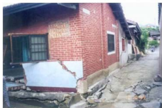
Figure 1 - 16 : Endommagement de bâtisses dû à la liquéfaction à Taiwan (d'après Dr Hsein, 2002).
