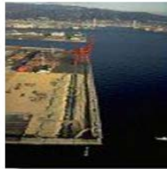
(d) Murs de quai poussés de 2 -3 m et enfoncés de 3 - 4 m
