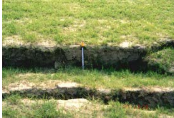
Figure 1 - 14 : Fissures considérables dans le sol à Nantou.
