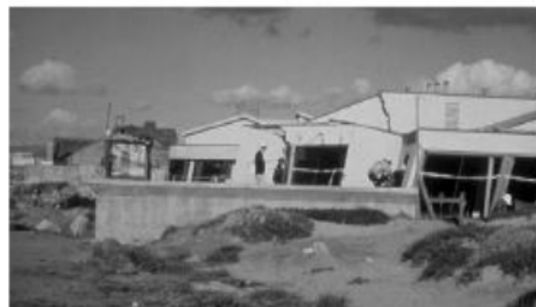
Figure 1 - 9 : Epanchage latéral le long de la route Sandholdt (à gauche) et destruction d'un centre de recherche (à droite) à Moss Landing. (D'après le Earthquake Engineering Research Center, University of California, Berkeley; Elgamal et al, 2001).
