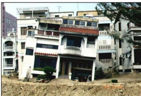
Figure 1 - 16 : Endommagement de bâtisses dû à la liquéfaction à Taiwan (d'après Dr Hsein, 2002).
