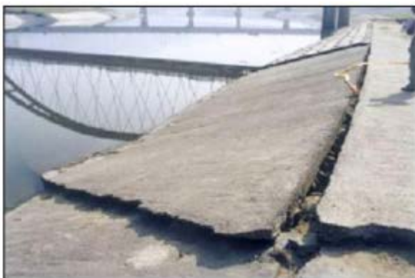
Figure 1 - 13 : Dommages dus à l'épandage latéral du sol en place.
