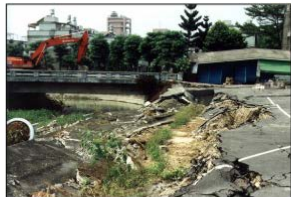
Figure 1 - 13 : Dommages dus à l'épandage latéral du sol en place.
