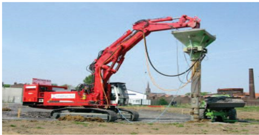
FIGURE 3.9: Colonnes ballastées.[9]
