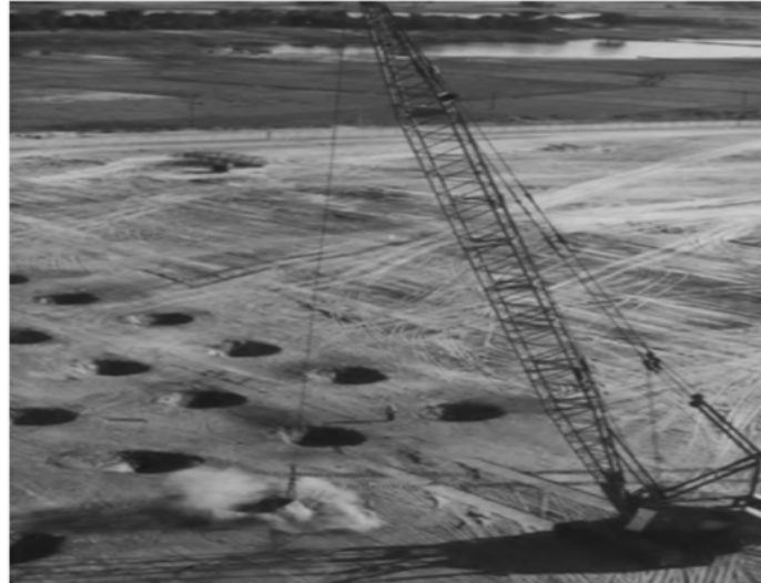
FIGURE 3.2: Compactage dynamique profond, en montrant le schéma des points d'impact primaire.[3]
