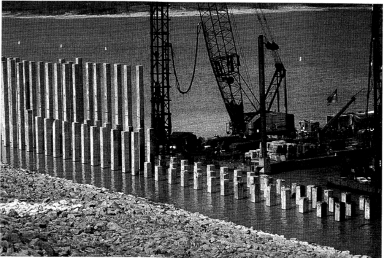
FIGURE 3.5: Piles de compaction pour réduire les risques de liquéfaction. L'entrepreneur a conduit les piles à ce niveau avec un marteau conventionnel ; Les piles ont ensuite été conduites sous la surface de l'eau avec un marteau différent.[3]
