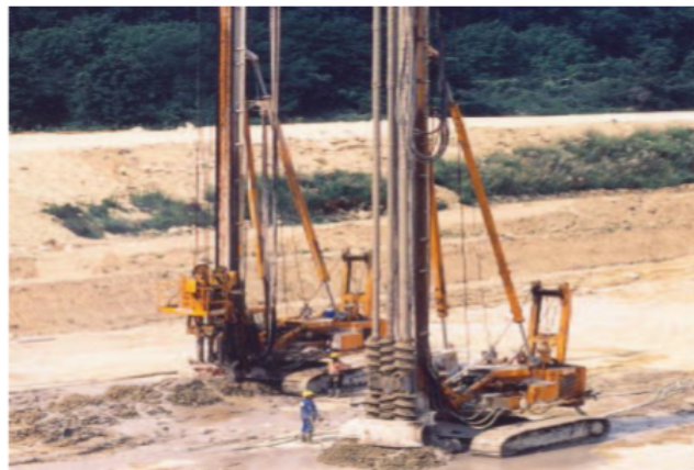
FIGURE 3.11: Amélioration de sol par soil mixing.
