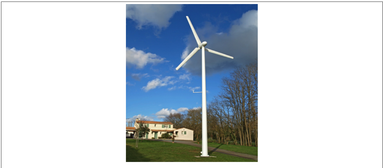
Figure 1.7 – Eolienne a axe horizontale
