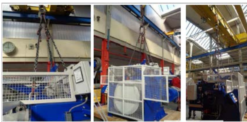
Figure VI.17. dispositif de d'enclos de protection des tréfileuses
