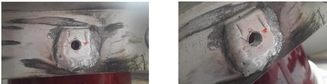
Fig. VI.5: perçage et taraudage des centres des cadres.
