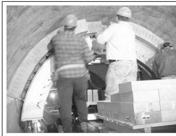
Fig. II.5 : brique conique étant installé dans le four rotatif [1].
