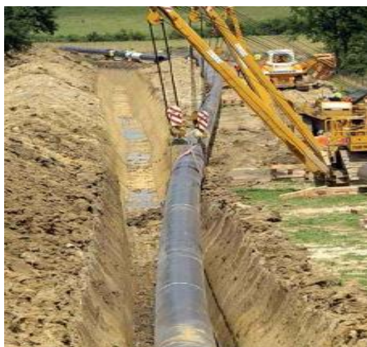
Figure II-5 : Mise en fouille des tubes
