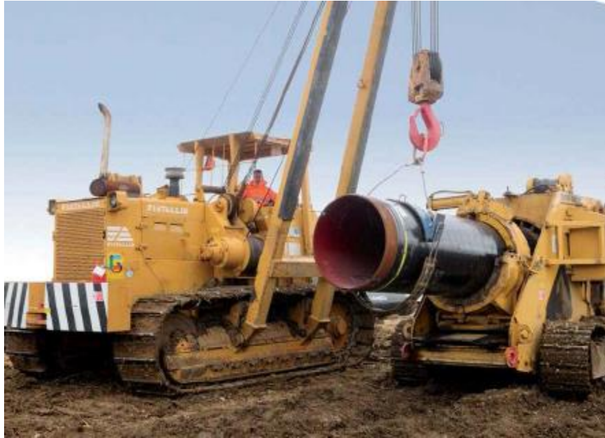
Figure II-2 : Cintreuse en action
