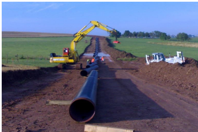
Figure II-1 : Bardage des tubes
