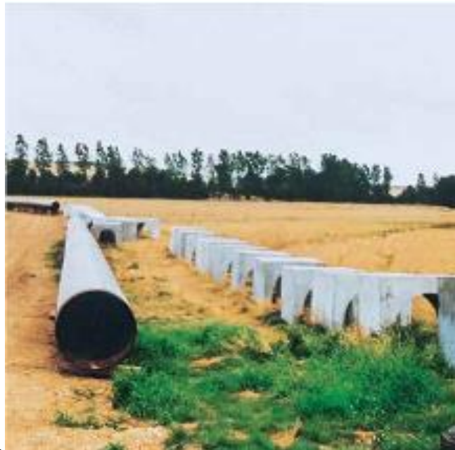
Figure II-6 : Cavalier de lestage en béton bardés
