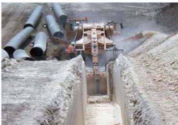
Figure II-4 : Trancheuse en action
