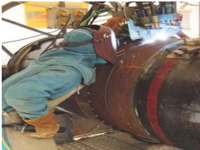
Figure II-3 : Soudure des tubes
