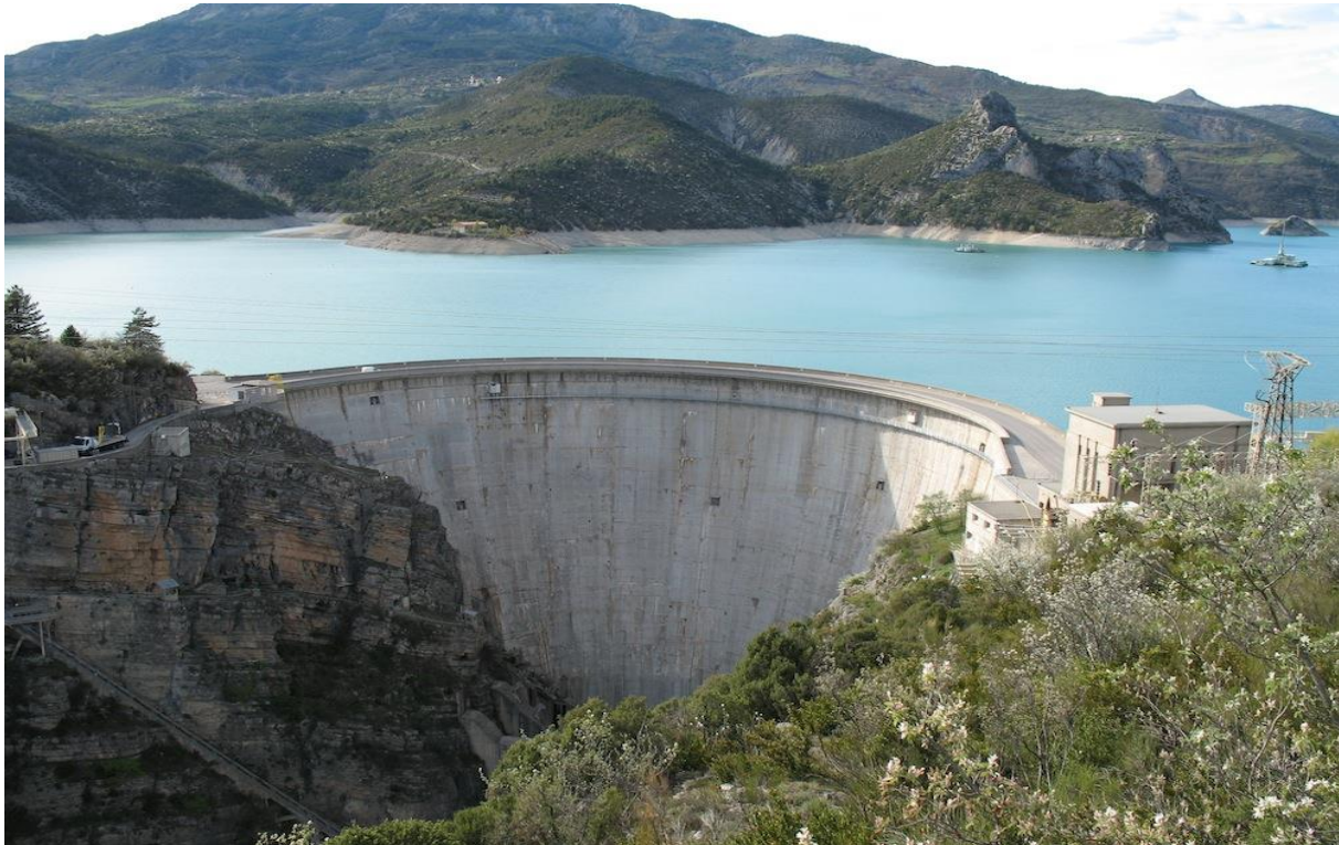
Figure I-14: Le barrage voûte de Castillon en France
