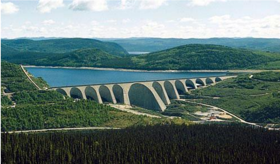
Fig1.2 Barrage à contrefort de Daniel Johnson au Canada.
