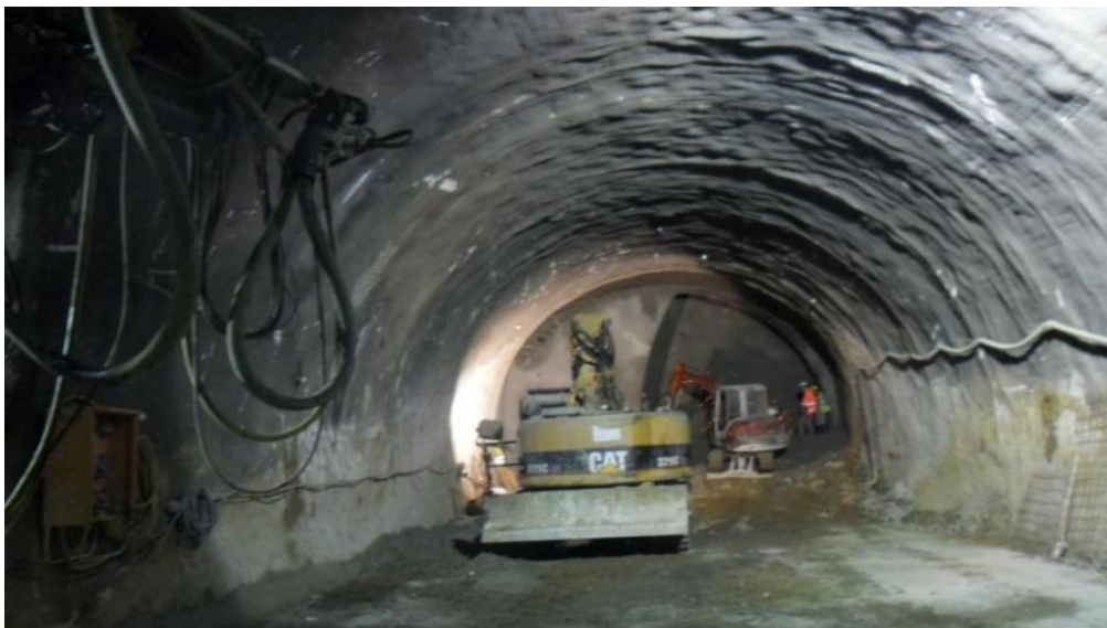
Figure VII.5 : Creusement de la première partie dévisée 3D [G3]
