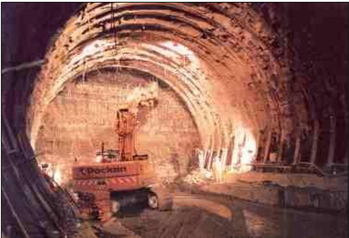
Figure III.1 : Creusement à pleine section [L3]
