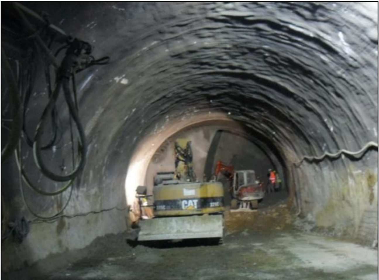
Figure III.3 : Creusement d'une section divisée [C1]
