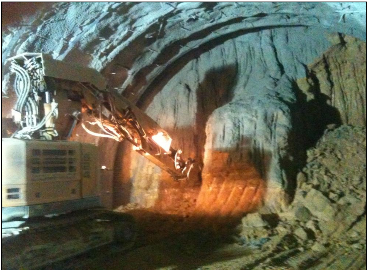
Figure III.2 : Creusement en demi-section [C1]
