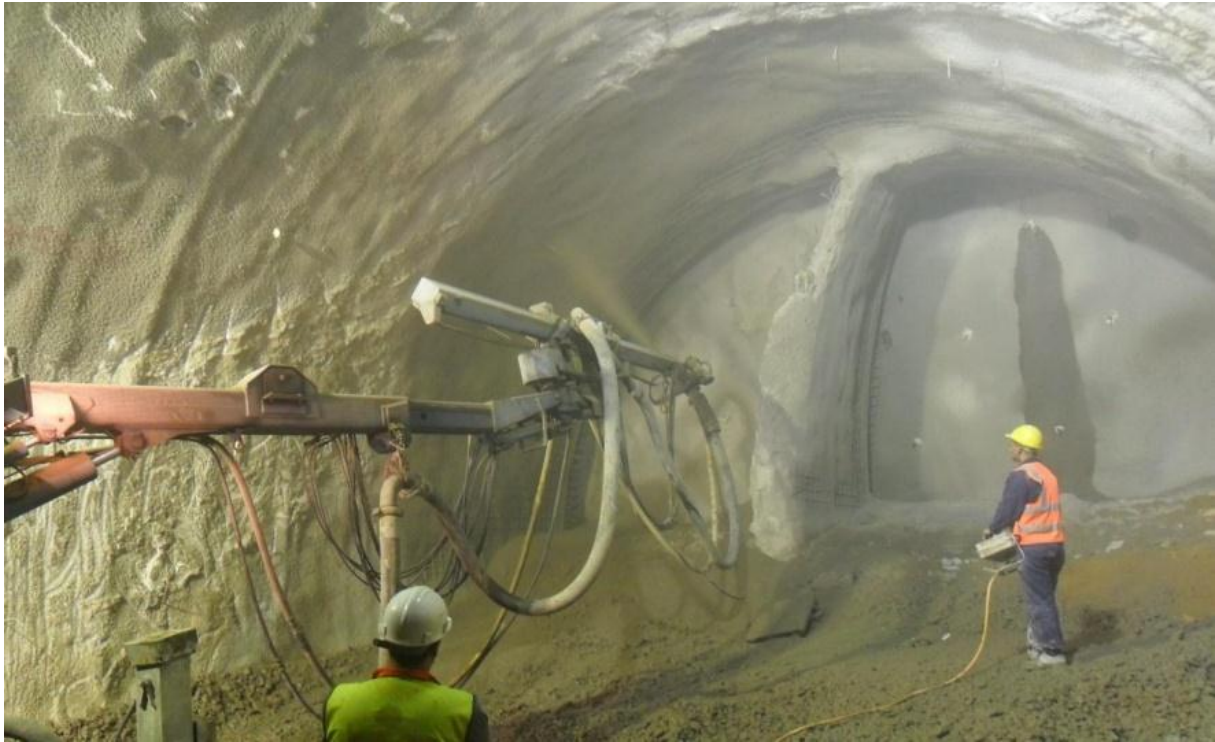
Figure VII.10 : Réalisation de la deuxième section divisée [G3]
