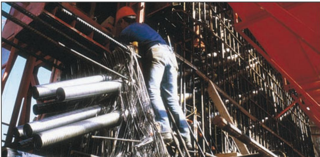
Figure 6.3 : Installation des gaines pour la post-tension.
