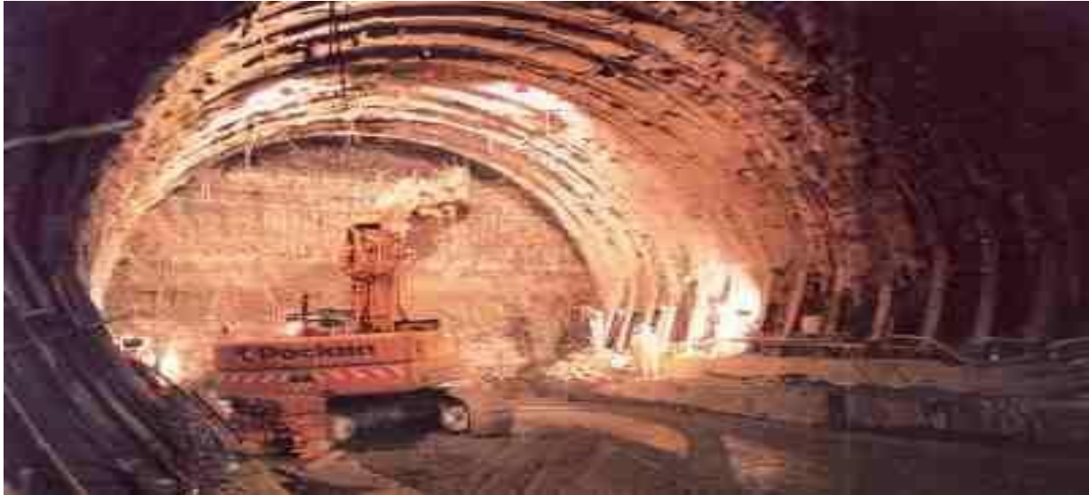
Figure II.1: Creusement en pleine section [WEB04]
