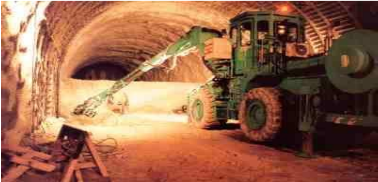
Figure II.2 : Creusement en demi-section [WEB05]
