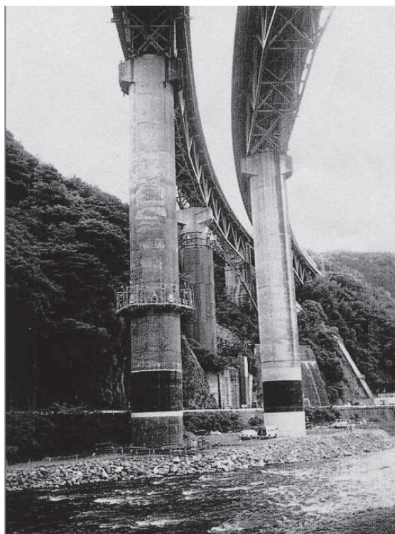
Figure II.16. Sakawa River Bridge au Japon 8 piles renforcées
