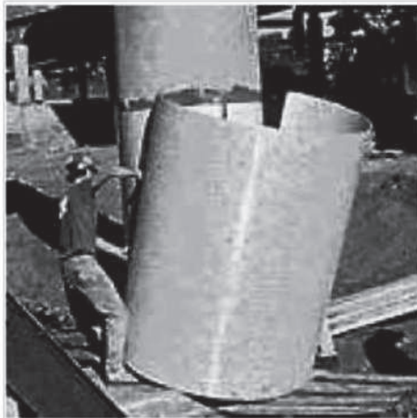
Figure II.20. Enchemisement avec FRP préfabriqué (gauche) et in-situ (droite)
