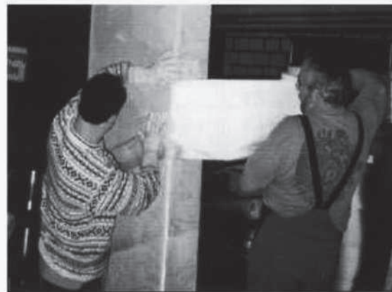
Figure II.20. Enchemisement avec FRP préfabriqué (gauche) et in-situ (droite)
