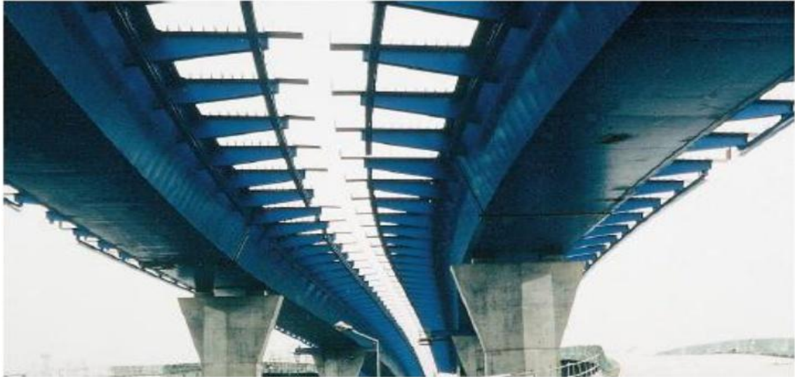
Figure. I.6. Exemple de pont caisson mixte [4]
