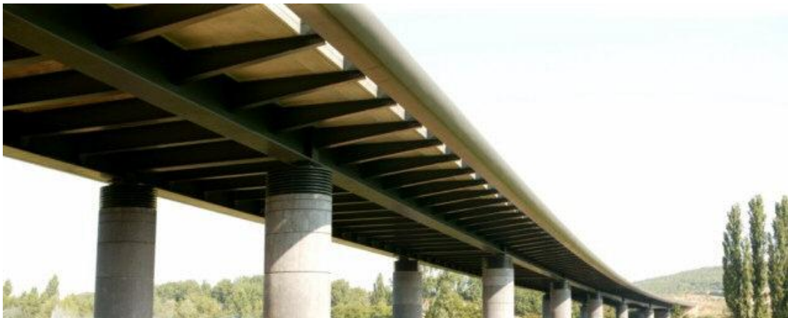
Figure. I.5. Exemple de pont mixte bipoutre
