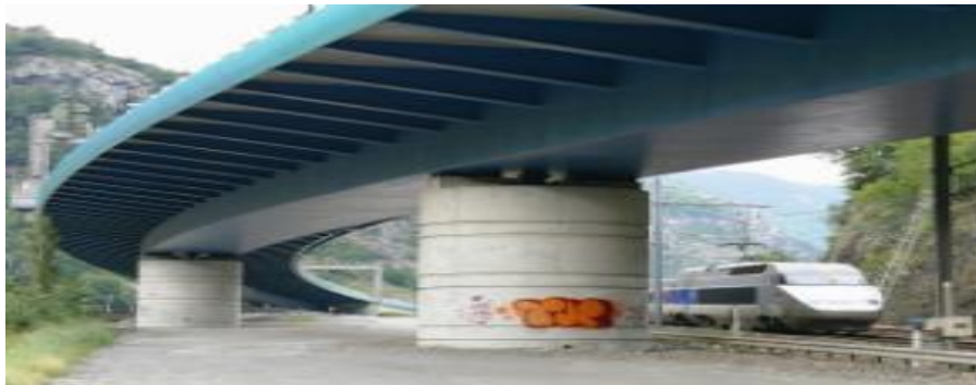
Figure II.4: Caisson à pièce de pont avec consoles.
