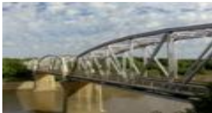
Figure. I.11. Pont à tablier inférieur
