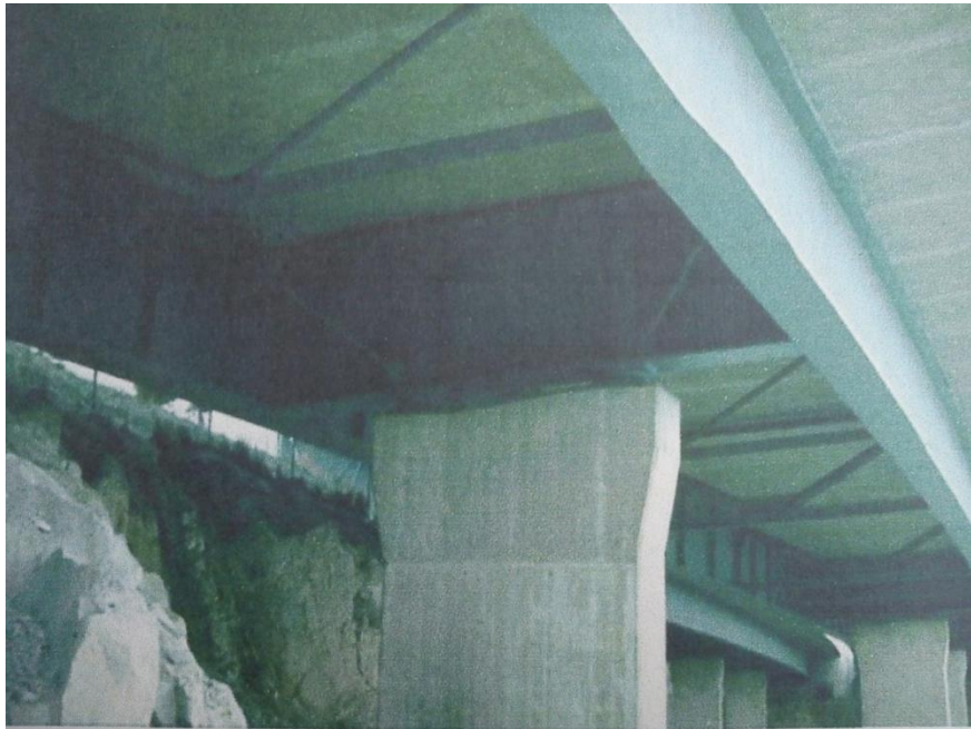
Figure. I.5. Exemple d'un bipoutre mixte
