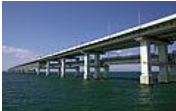
Figure. I.13. Pont à double tablier
