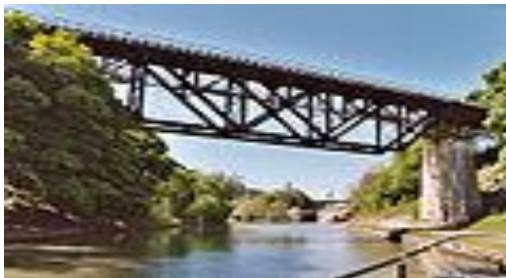
Figure. I.10. Pont à tablier supérieur
