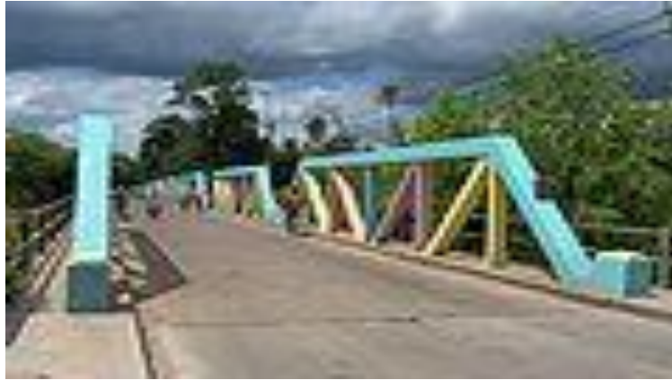
Figure. I.12. Pont en treillis Pony
