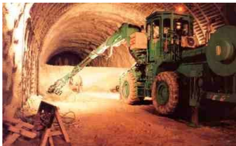
Figure III.2 : creusement en demi-section
