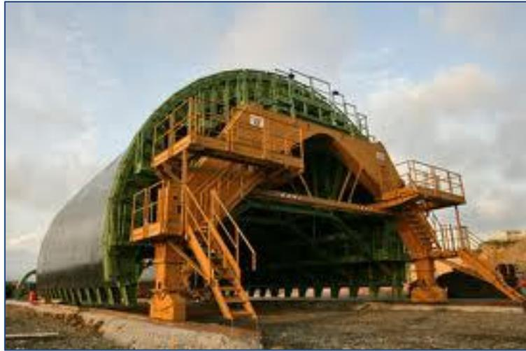
**Figure IV.5: Exemple de coffrage de tunnel.**
