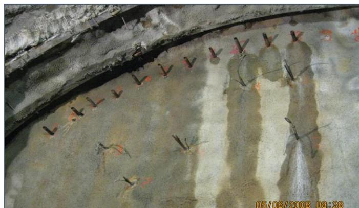
Figure II.21: Renforcement du tunnel à l'aide de boulons (photo prise dans la section D6).
