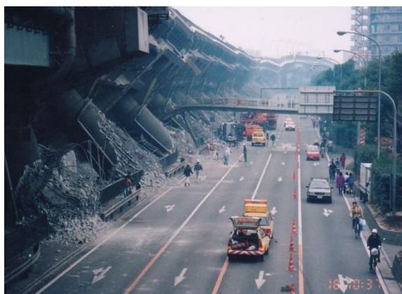
Figure 1.1 : Effondrement d'un Viaduc lors du séisme de Kobe (1995) en raison de la liquéfaction du sol [2]
