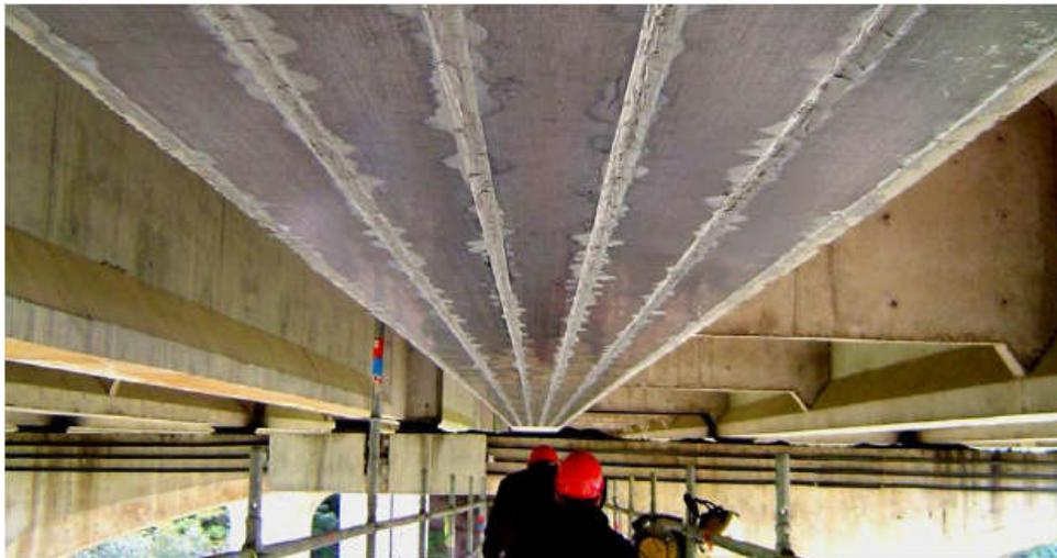
**Figure 2-7 Renforcement d'un pont tôles colées sur l'autoroute A6 près de Toutry. [1]**
