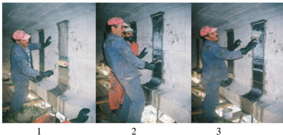
Figure 2-13 Différentes étapes d'application de TFC
