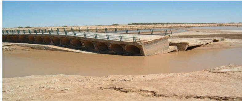
**Figure 2-1 Affouillement du pont (oued Dj dai à Biskra)**
