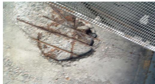
**Figure 2-2 Corrosions des armatures d'un tablier de pont**
