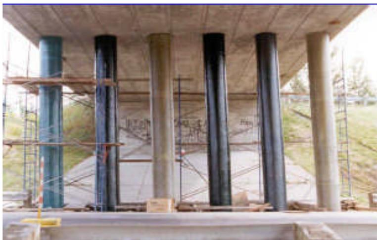
Figure 2-9 piles d'un pont renforcées par composites à fibres de carbone
