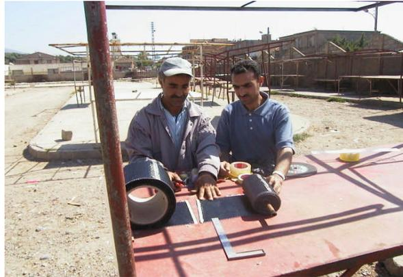
**Figure 2-12 Découpage de TFC (suivant la note de calcul)**
