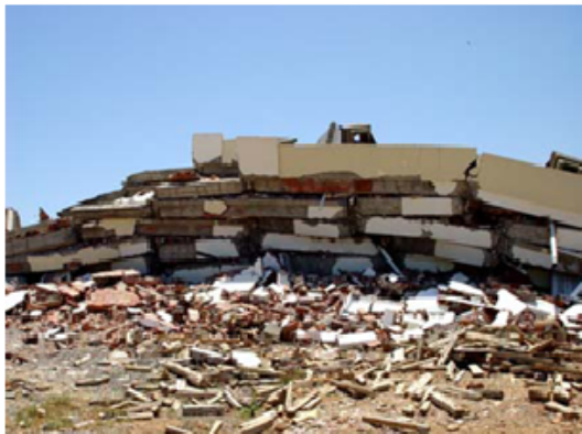
Effondrement d'un bâtiment R+6
