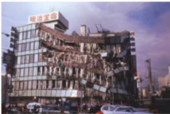
Séisme de Kobé, Japon 1995
