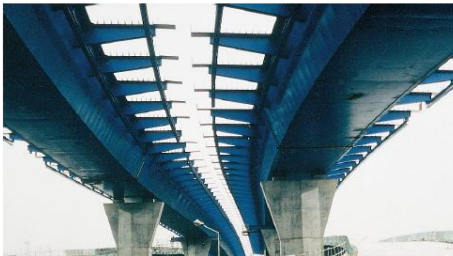
Figure. I.7. Tablier en caisson mixte [3]
