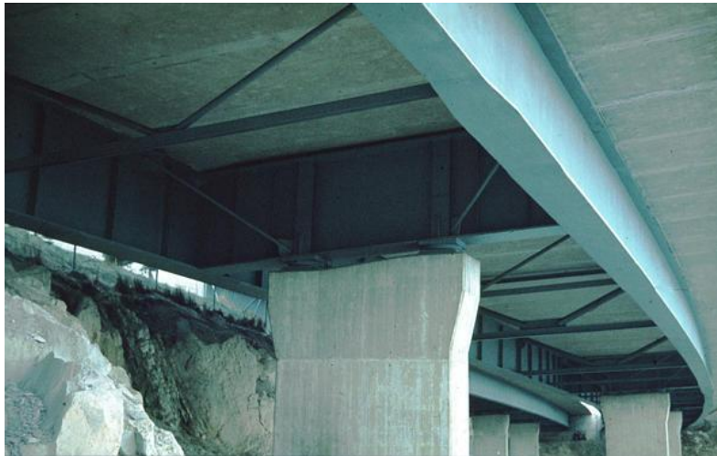
Figure. I.5. Exemple de pont mixte bipoutre
