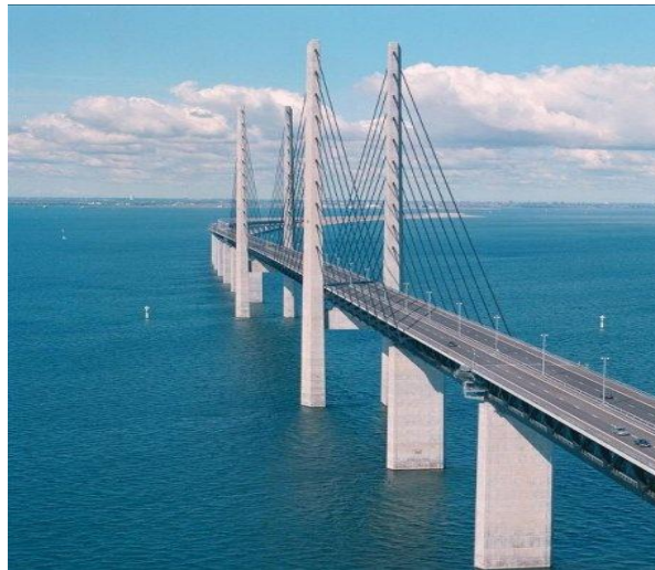
Figure. I.6. Exemple de pont à haubans
