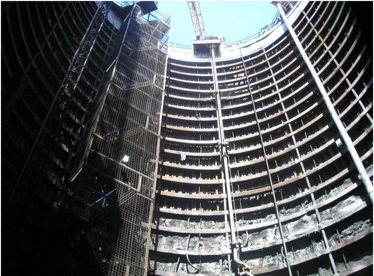
**Figure 4-14** Soutènement d'un puit
