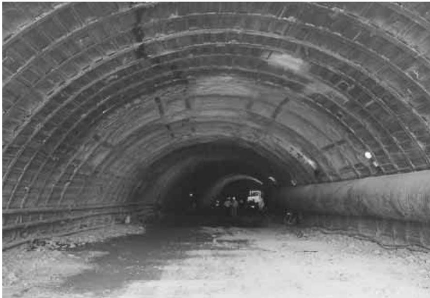
**Figure 4-7** Profil de soutènement avec cintres lourds
