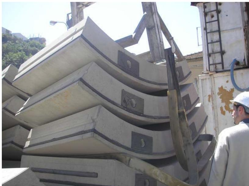
**Figure4-13** Voussoirs en béton
