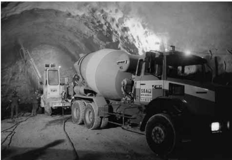
**Figure4-12** Béton projeté
