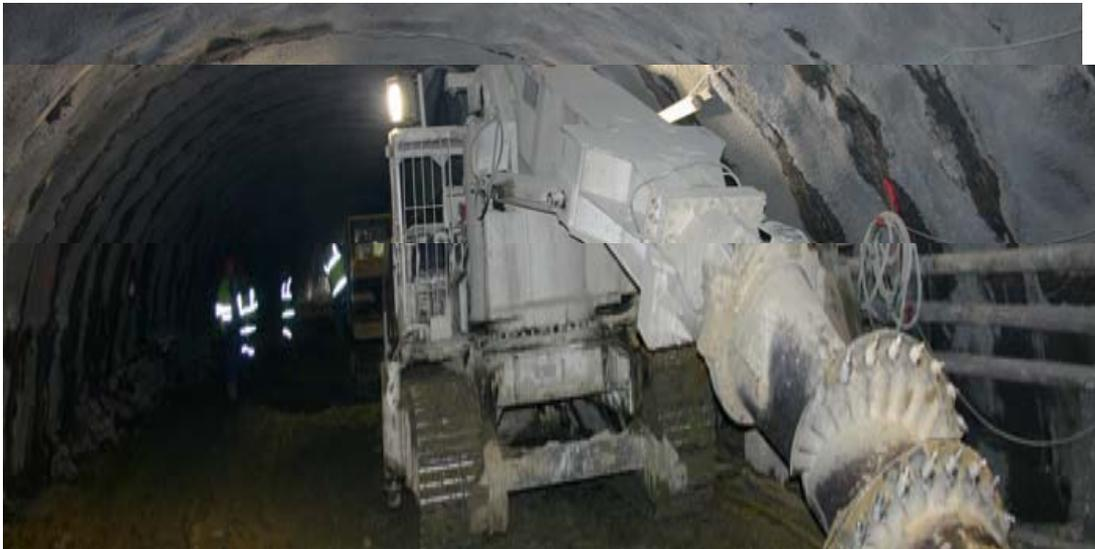
**Figure3-5** Machine à attaque ponctuelle
