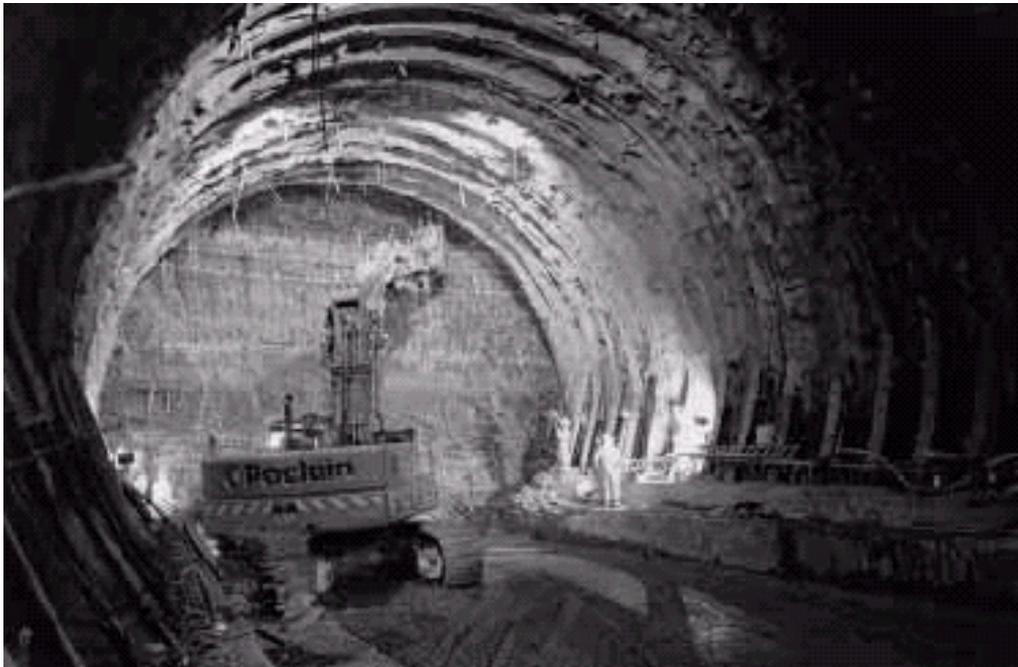
**Figure 3-1** Creusement en pleine section
