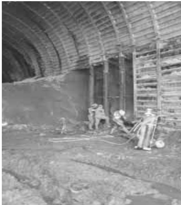
**Figure4-11** Soutènement par blindage
