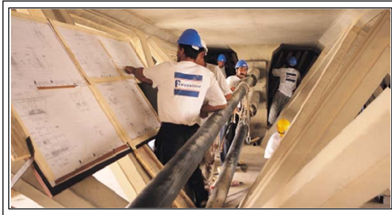
Figure 2-46: Câbles extérieurs, intérieur du tablier du pont de Bubiyan, au Koweït
