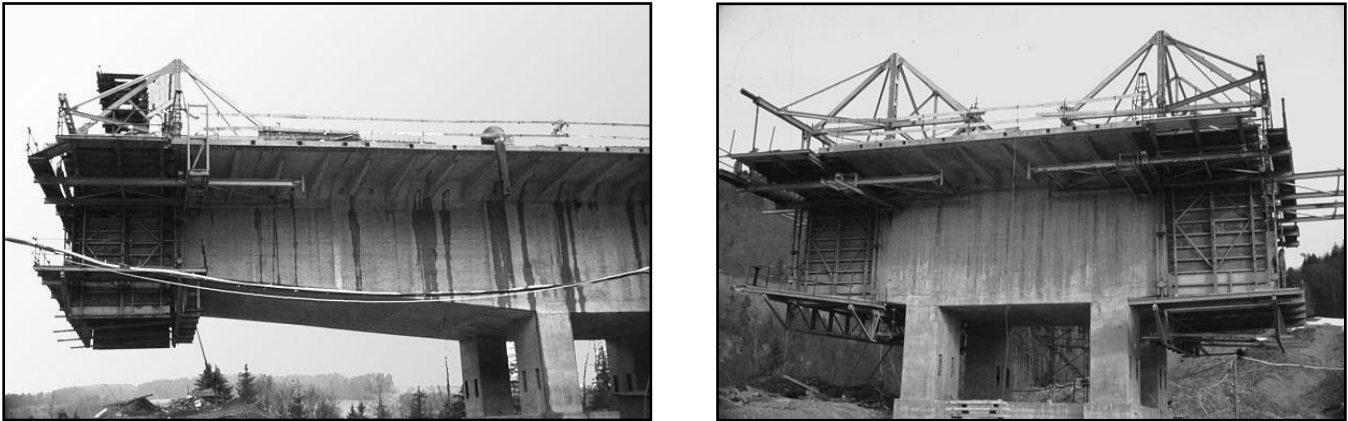
Fig. I.4. Voussoirs coulés sur place
