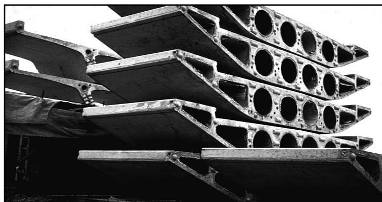
Fig. I.3. Stockage des voussoirs préfabriqués
