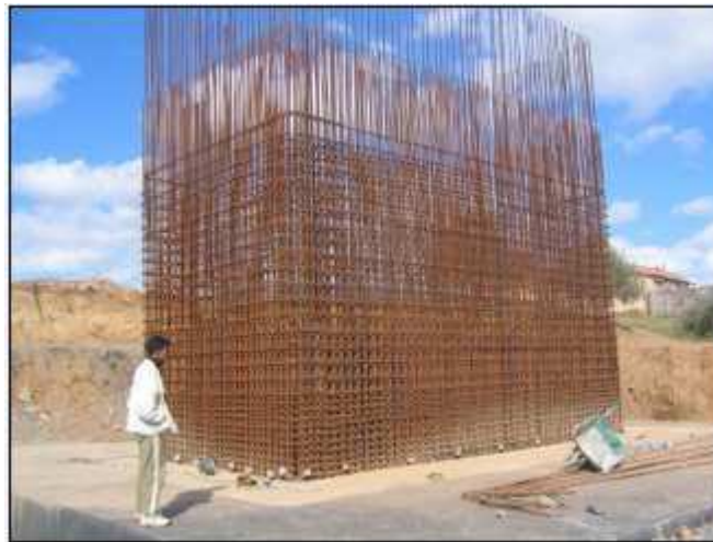
Fig. VIII.5. Ferrailage transversal de la pile
