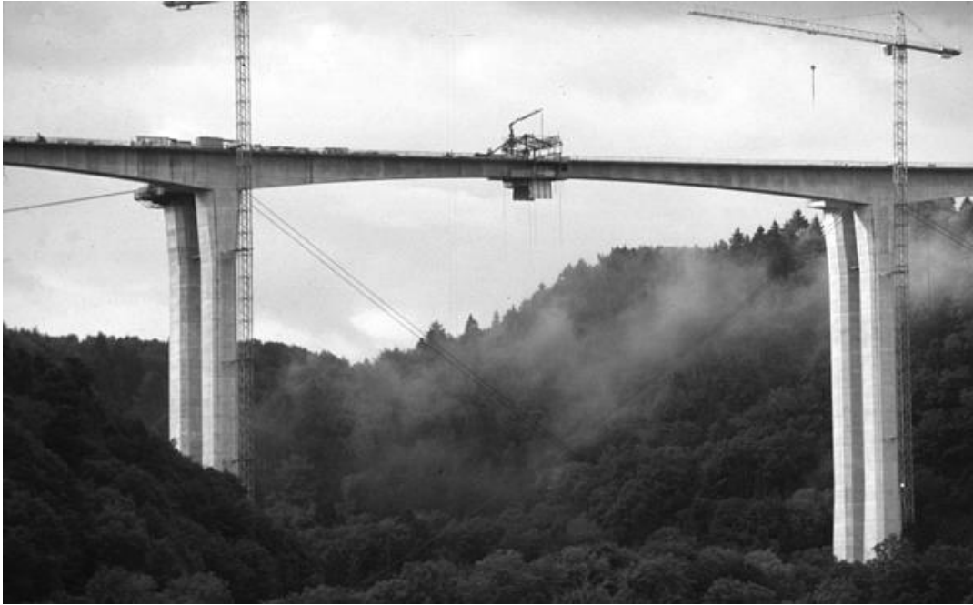
Fig. I.5. Coulage du voussoir de clavage
