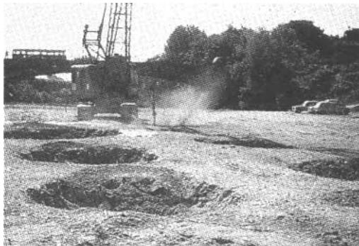
**Fig.2.5.** Chantier de pilonnage.
