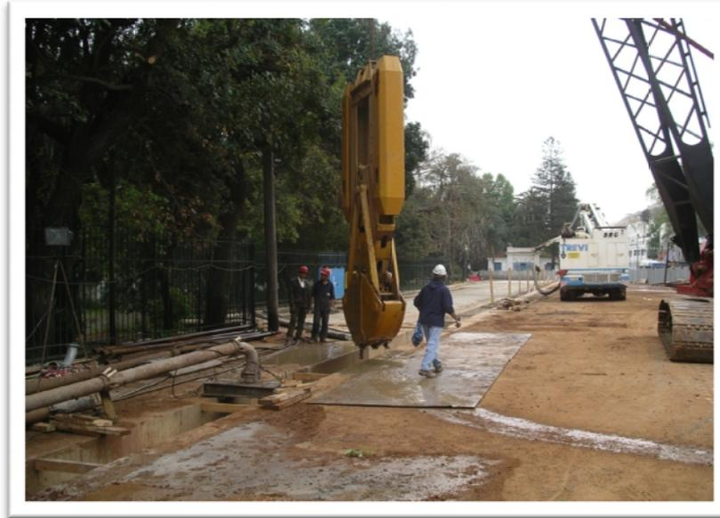
Figure III. 1 : Benne preneuse (photo reproduite avec la permission de Metro d'Alger)
