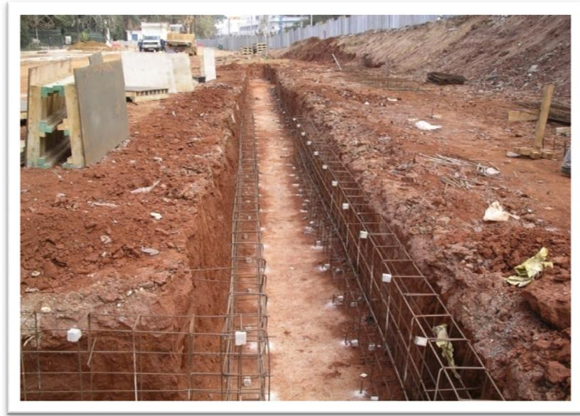
**Figure III. 7 :** Tranchée guide (photo reproduite avec la permission de Metro d'Alger)
