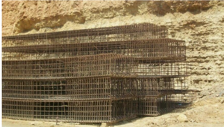
Figure IV.6 : des cages d'armatures (photo reproduite avec la permission de l'ANA)
