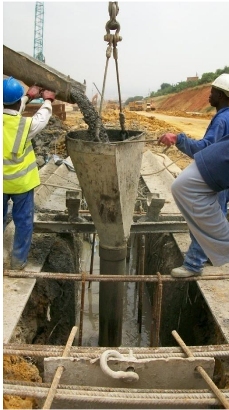
Figure IV.5 : bétonnage de la paroi (photo reproduite avec la permission de l'ANA)
