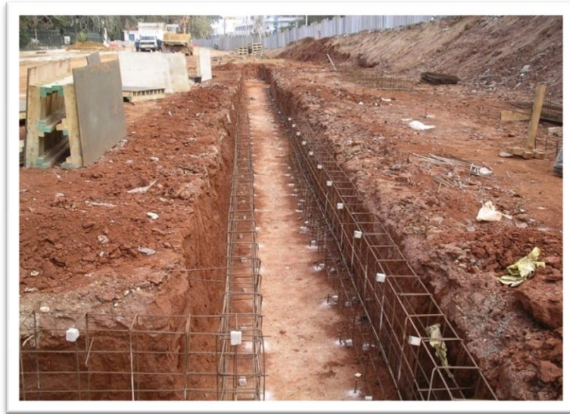
figure IV.7 : tranchée guide
