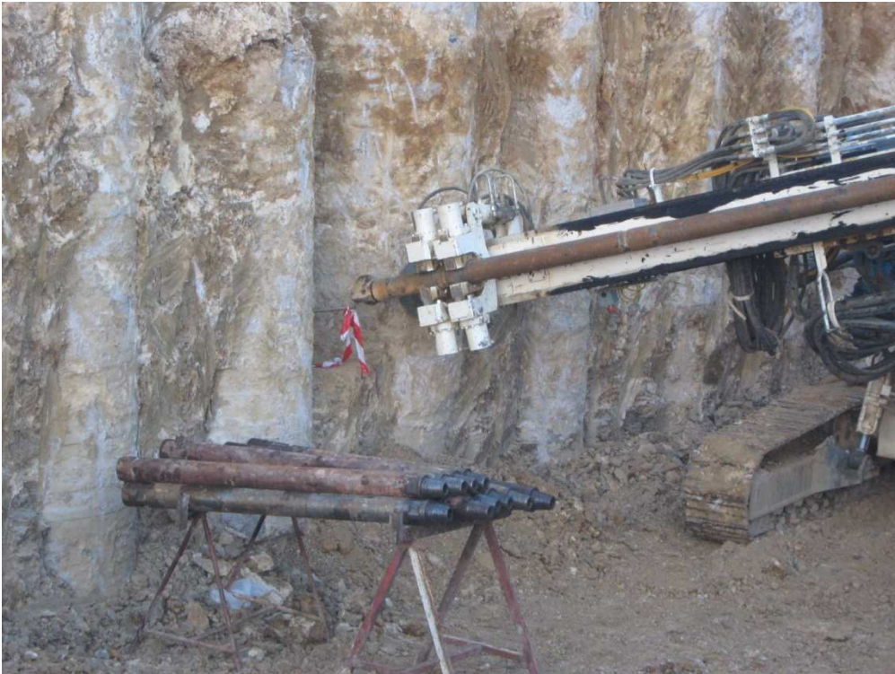
Fig.6 : Traçage des tirants d'ancrage.
