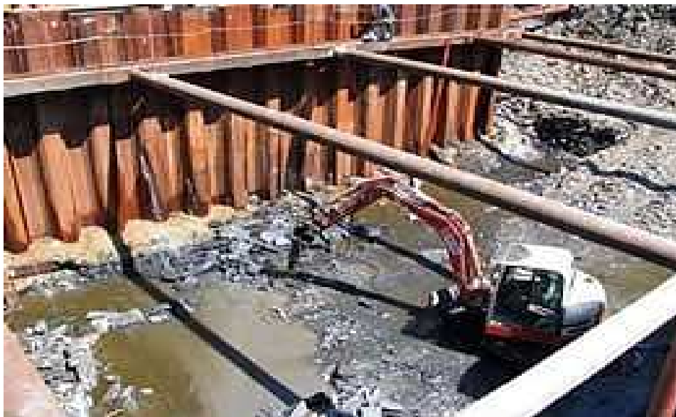
Fig. III.3. Palplanches métalliques
