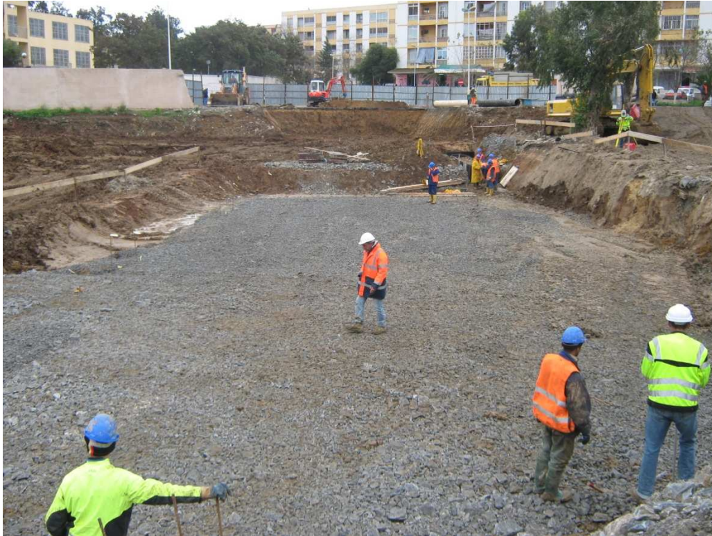
Fig.2 : Réalisation de la plate-forme de travail
