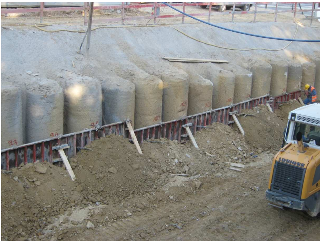
Fig.5 : le soutènement avec des pioux forés.
