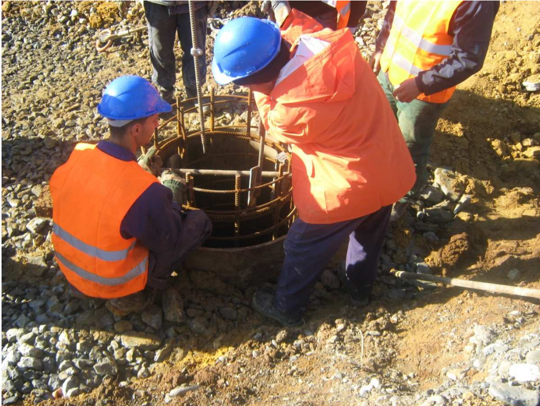
Fig.4 : Mise en place de la cage d'armature.
