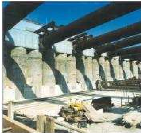
Fig.III.4 : Pieux sécants
