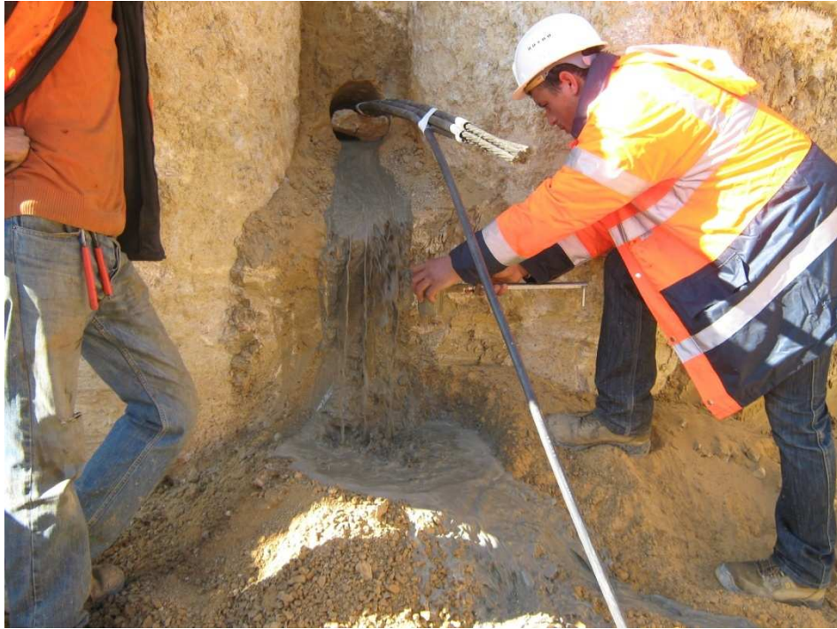
Fig.8 : Mise en place et injection du tirant.
