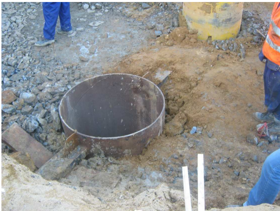
Fig.3 : Installation du tubage provisoire.
