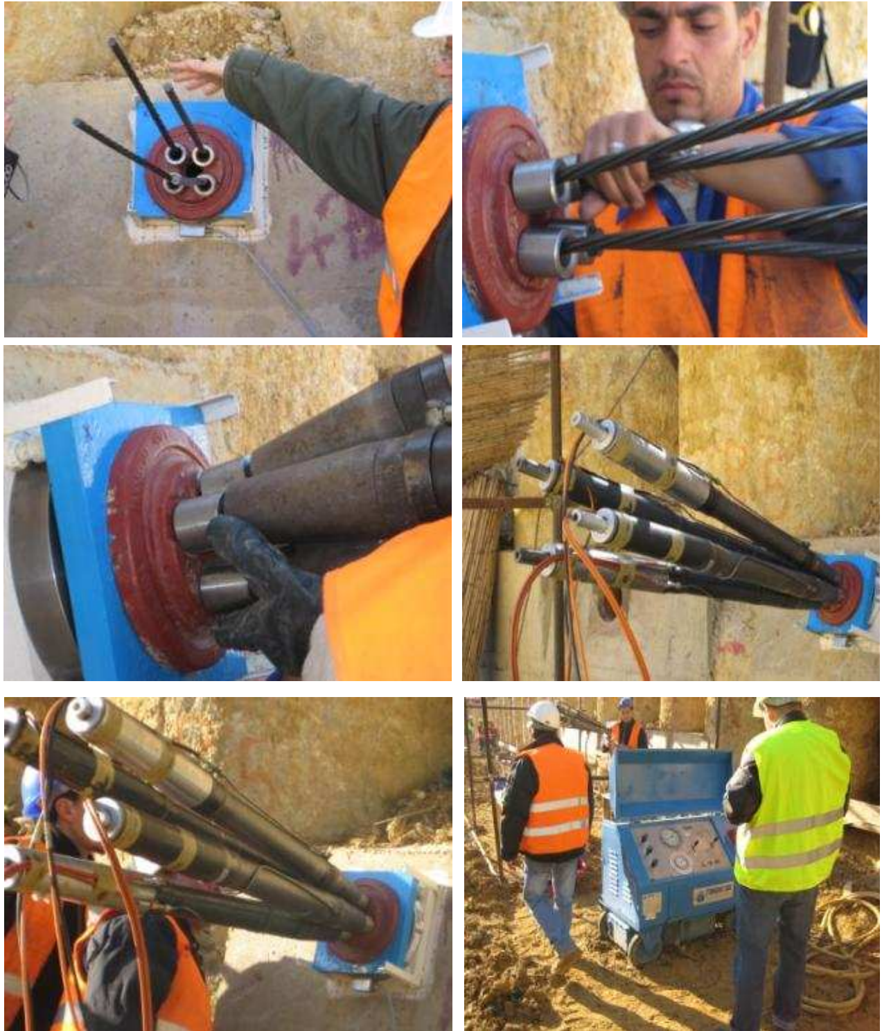
Fig.10 : Mise en tension et blocage des tirants d'ancrage
