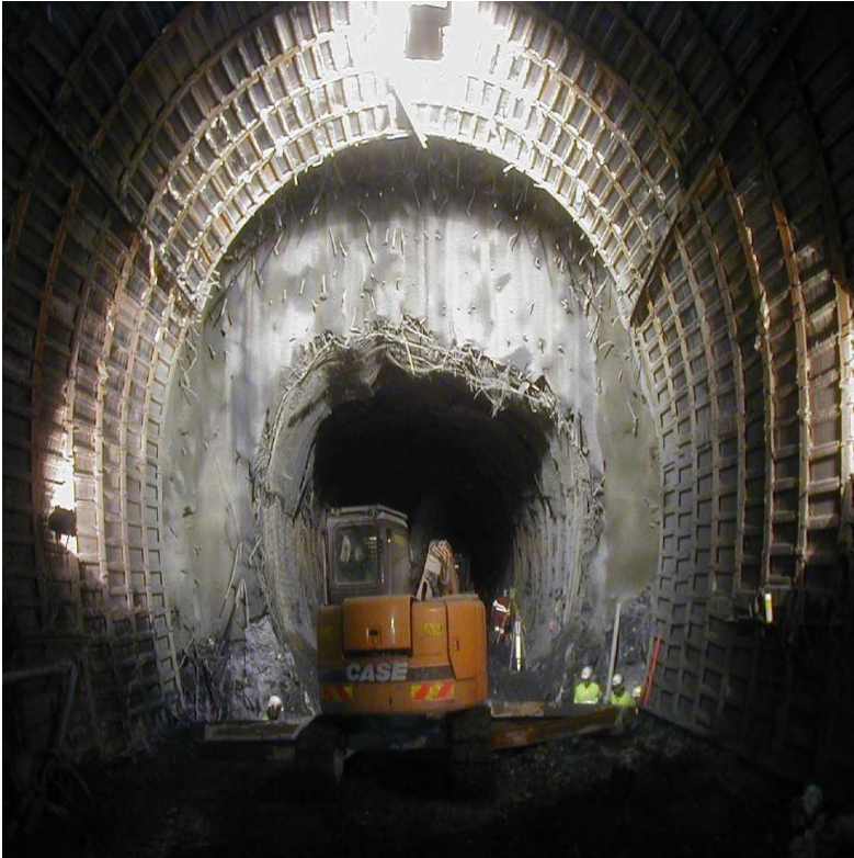
Figure I. 1. Exemple d'une galerie de reconnaissance
