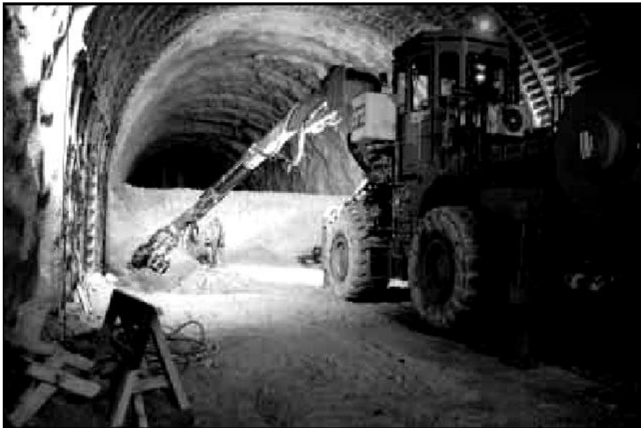
Figure II.2. Creusement en demi-section
