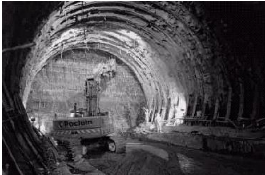
Figure II.1. Creusement en pleine section
