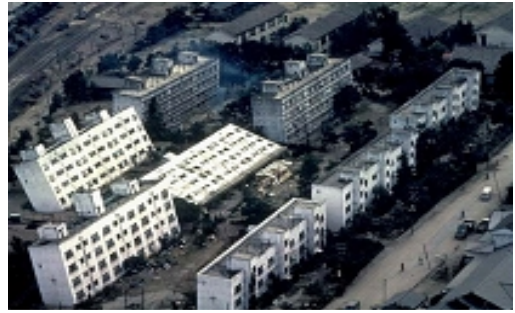
Figure. 7-4 : Séisme de Niigata (Japon) le 16 juin 1964 de magnitude 7.5 : à cause de la liquéfaction du sol
