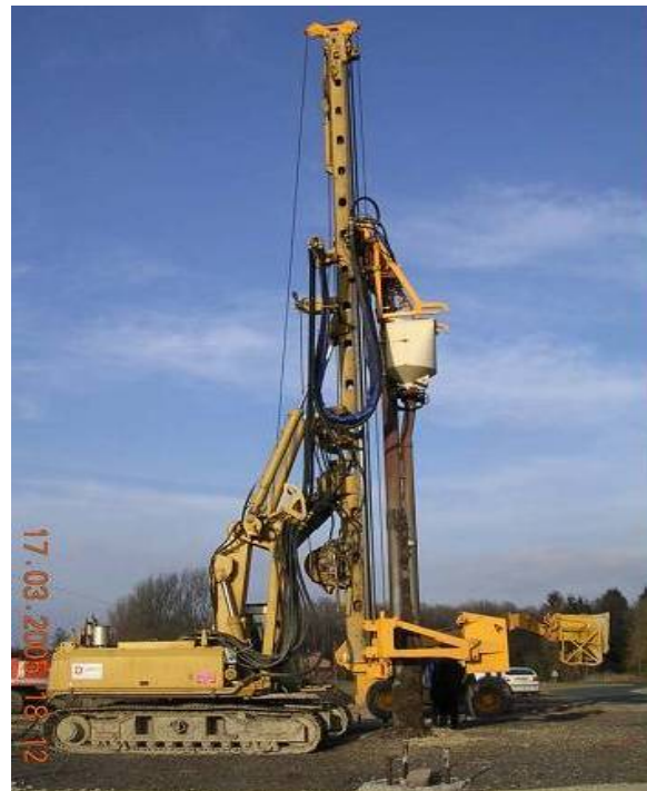
Figure 7-10 Grue portant le vibreur à sas
