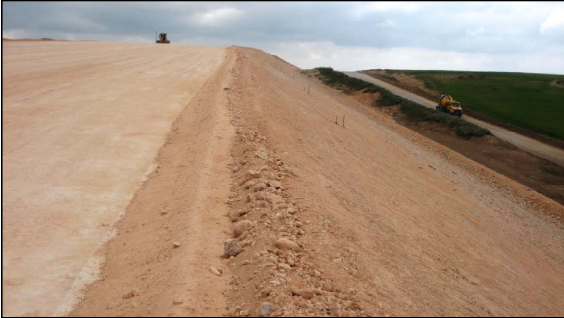
Figure V-1: Vue du projet en cour de réalisation
