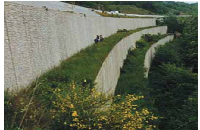
Figure VI-18: Ouvrage en remblai renforcé après la construction.
