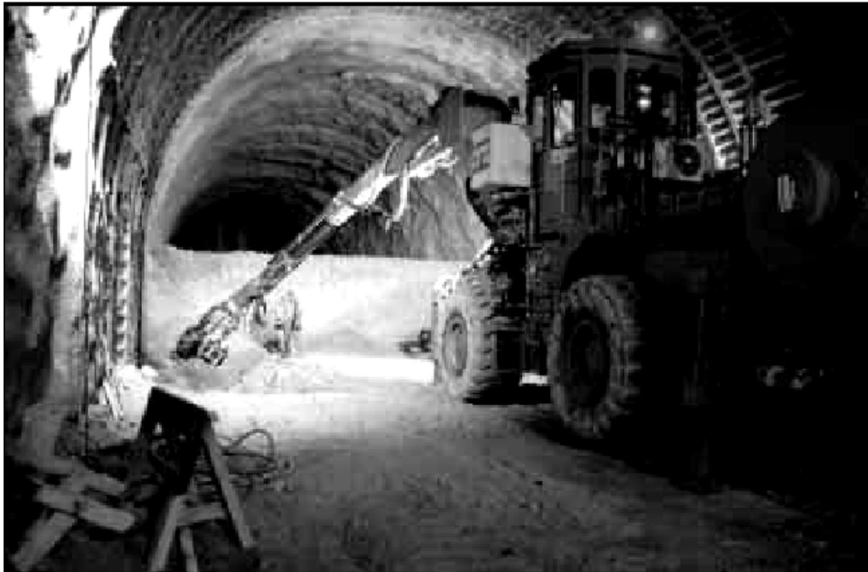
Figure 3-2 Creusement en demi section
