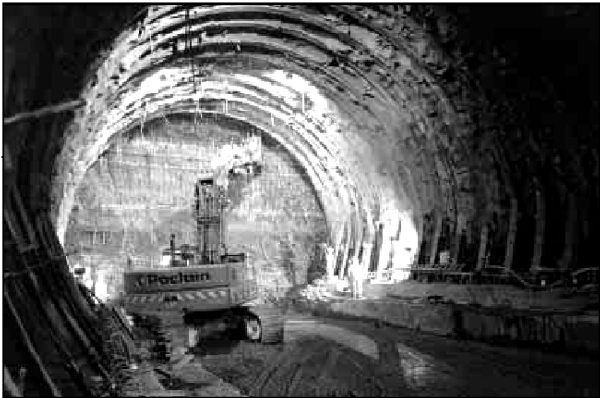
Figure 3-1 Creusement en pleine section (tunnel de Tartaignille)
