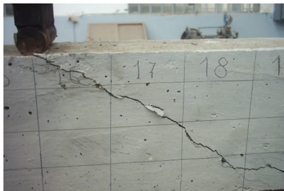
Figure 3.13b : Fissuration de la poutre 2 à la rupture
