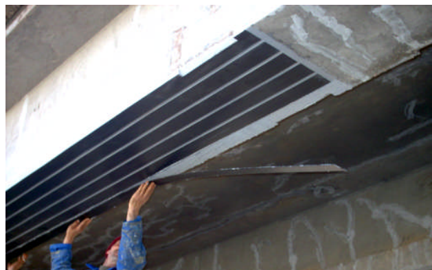
Figure 1.1a : Collage des lamelles
