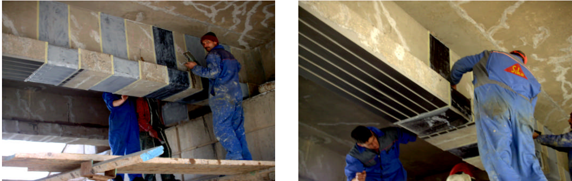
Figure 1.1b : Pose du tissu SIKAWRAP
