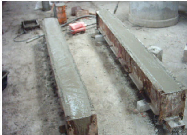
Figure P4 : Coulage des poutres
