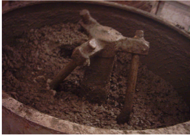
Figure P3 : Malaxage du béton
