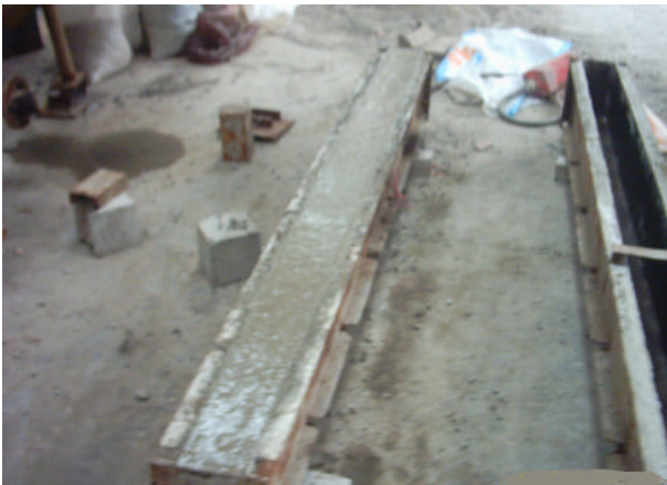
Figure P4 : Coulage des poutres
