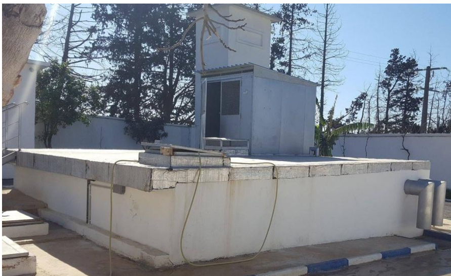
Figure 01 : La bache d'aspiration de la station SP5.
