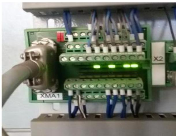
**Figure I-13: terminal des entrées sorties binaires**
