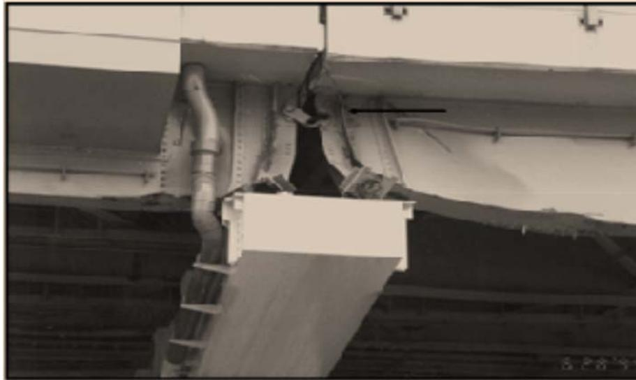
Figure 1.4. Entrechoquement des tabliers adjacents du a une rupture des appareils d'appuis
