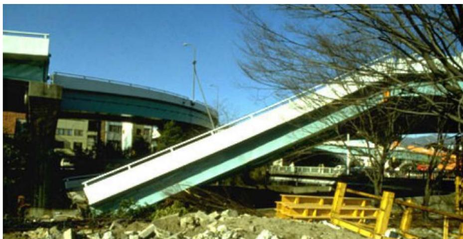
Figure 1.1. Chute du tablier d'un pont lors du tremblement de terre de Kobe en 1995
