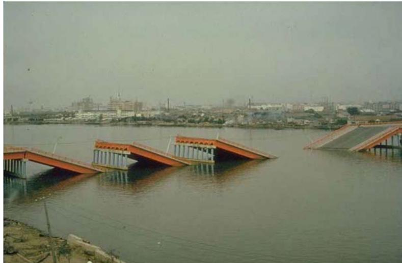
Figure 1.12. Rupture de pont de SHOWA, causée par la liquéfaction de sol des fondations lors du séisme de NIIGATA 1964
