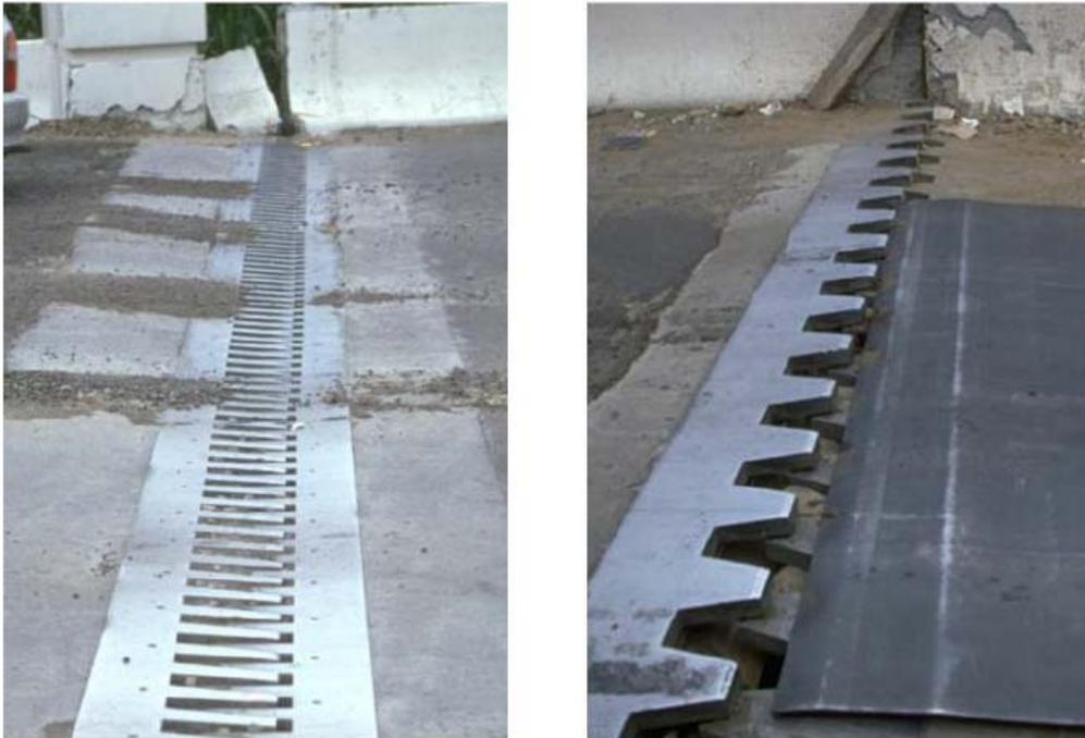
Figure 1.16. Joints de chaussée endommagés, séisme de Taiwan 1999
