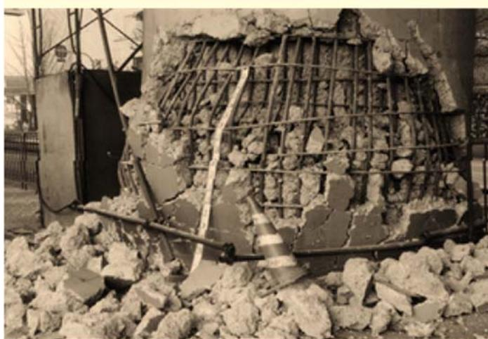
Figure 1.8. Rupture fragile due à une insuffisance de confinement du béton
