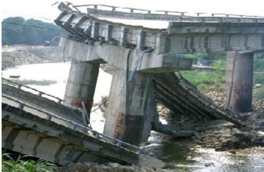
Figure 1.2. Effondrement du tablier d'un pont à poutres préfabriquées lors du tremblement de terre de Taiwan 1999
