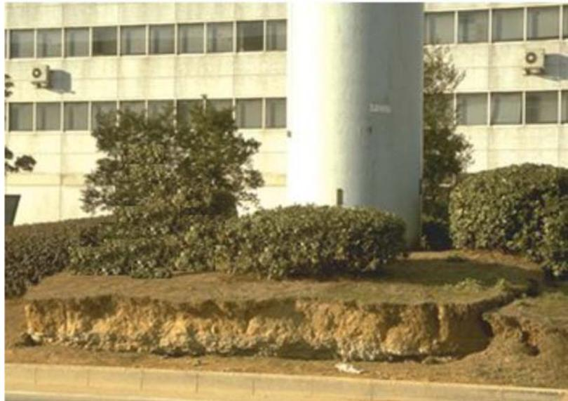
Figure 1.14. Tassements généralisés causés par la liquéfaction du sol autour de la dalle de fondation sur pieu d'une pile de pont, Kobe, 1995
