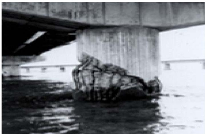
Figure 1.9. Rupture par cisaillement de la pille due au manque de ductilité suffisante, séisme de Urakawa 1982
