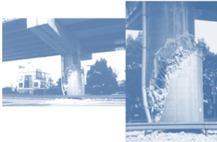
Figure 1.7. Rupture par cisaillement due à un grand espacement des armatures
