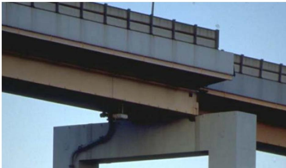
Figure 1.3. Déplacement latéral du tablier et chute des appuis sur la palée d'un pilier Kobe, 1995
