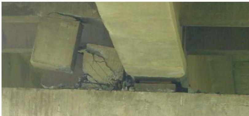
Figure 1.15. Appui longitudinal écrasé, sur la culée d'un pont à poutre, Boumerdès 2003
