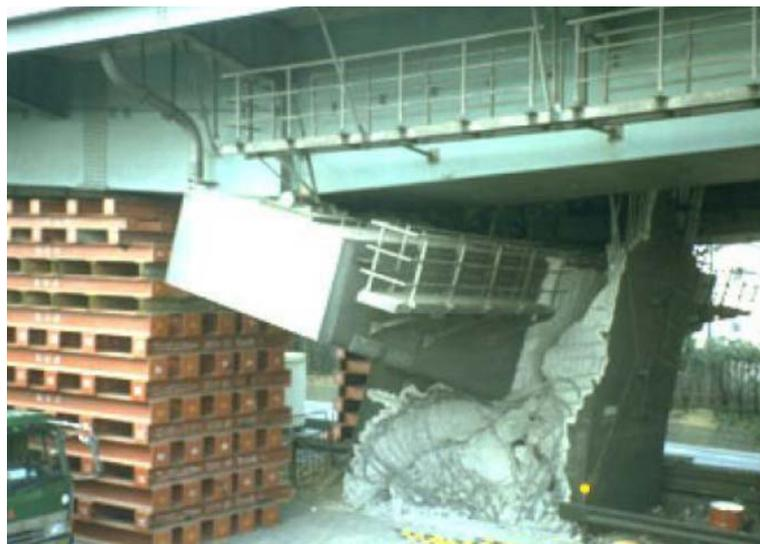
Figure 1.6. Ruine à l'effort tranchant d'une pile de pont en béton armé Kobe, 1995
