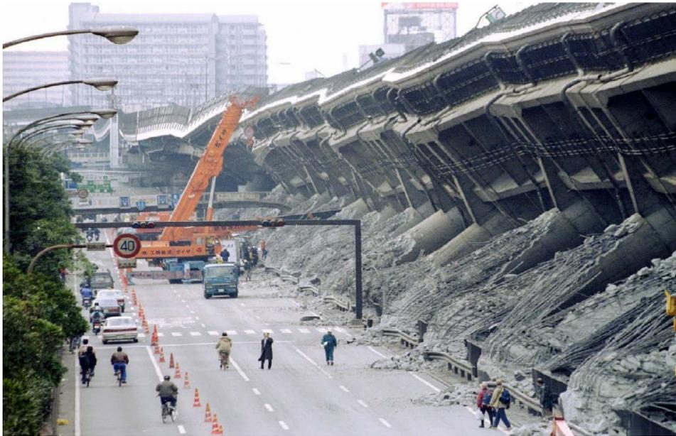
Figure 1.5. Ruine de piles de pont en béton armé Kobe, 1995
