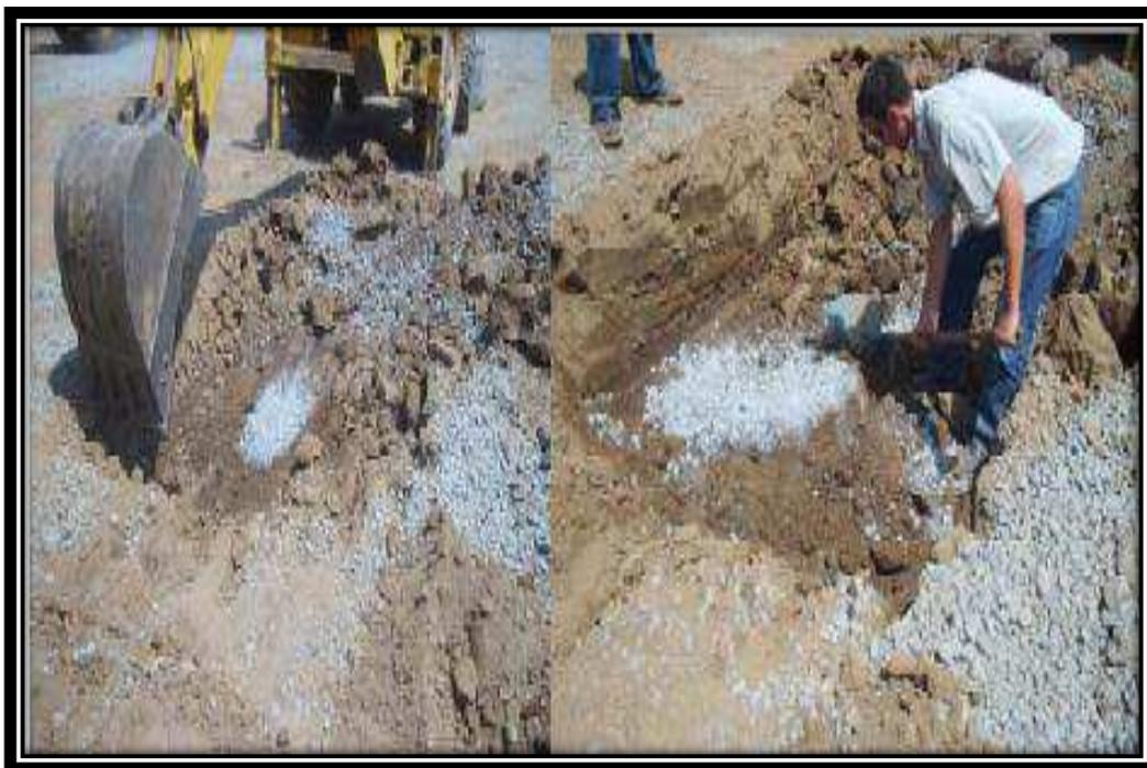
**Figure VI.1 : Dégarnissage d'une colonne**
