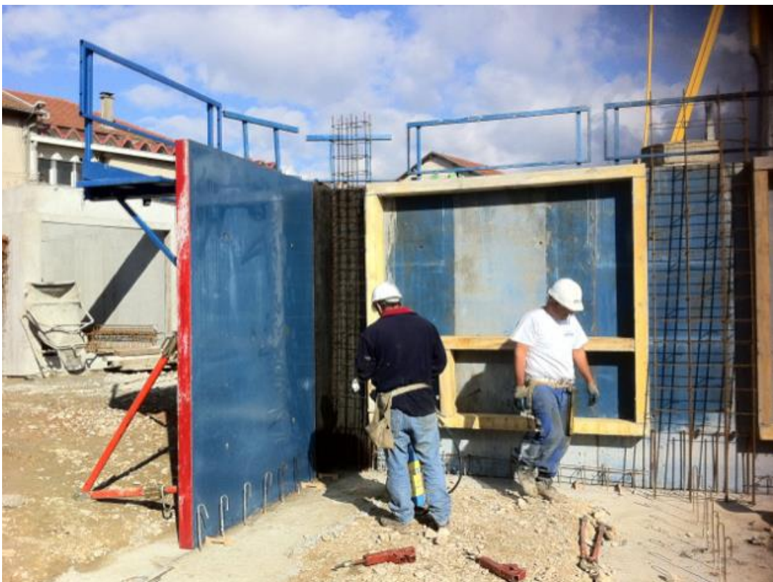
Figure 4.2 : Coffrage des voiles en banche
