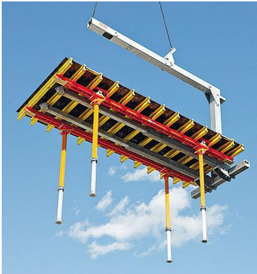
Figure 4.3 : Coffrage d'une dalle avec table
